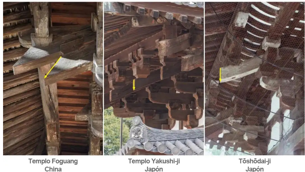
Figura 50: Cortes en extremo del brazo de soporte de alero (昂 “ang”) de China (izquierda) y Japón (derecha).
