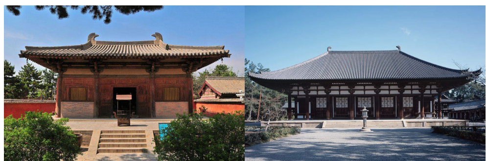
Figura 55-56: Salón principal del templo Nanchan en el monte Wutai de China (izquierda) y Salón Dorado del Tōshōdai-ji de Japón (derecha).
