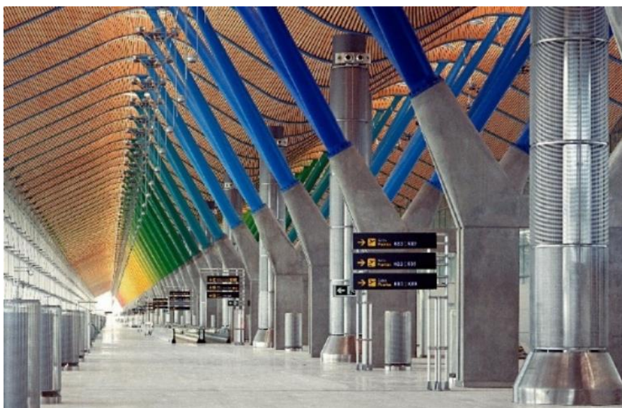
Ilustración 17. Interior edificio Terminal 4, Dique.
