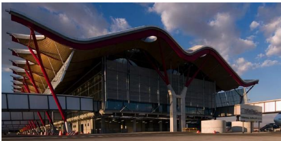
Ilustración 49. Exterior T4. Zona Sur Dique. Soleamiento de Poniente
