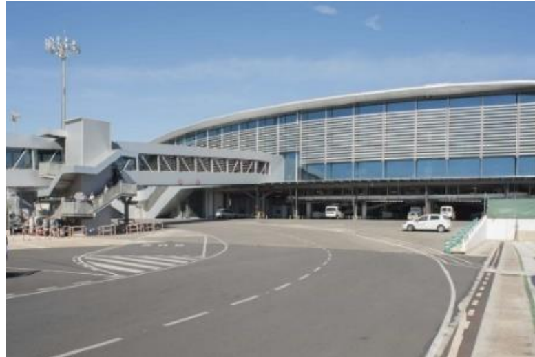
Ilustración 1. Exterior fachada T2_Valencia-Manises
