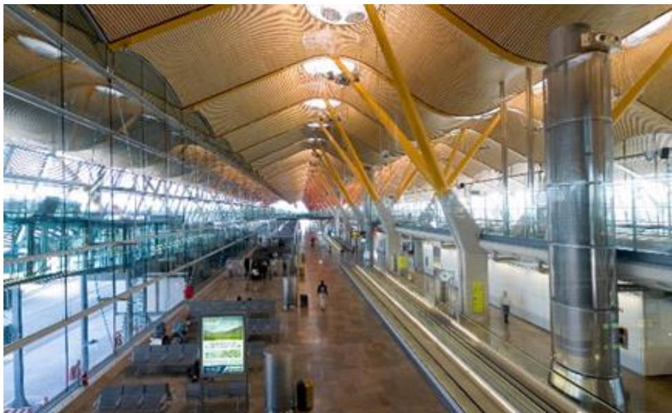
Ilustración 19. Interior T4: Dique
