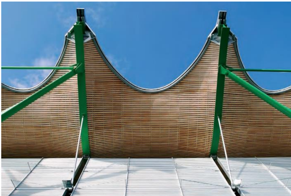
Ilustración 57. Elementos de sombra en fachada. Aleros + Parasol
