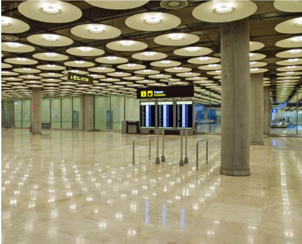
Ilustración 52. Pavimento de piedra natural caliza. Recogida de equipajes.
