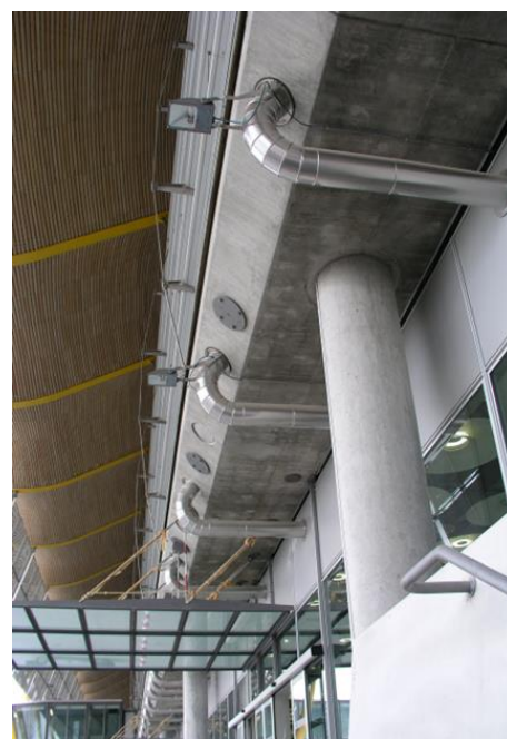
Ilustración 67. Imagen exterior Sistema Perimetral de Climatización
