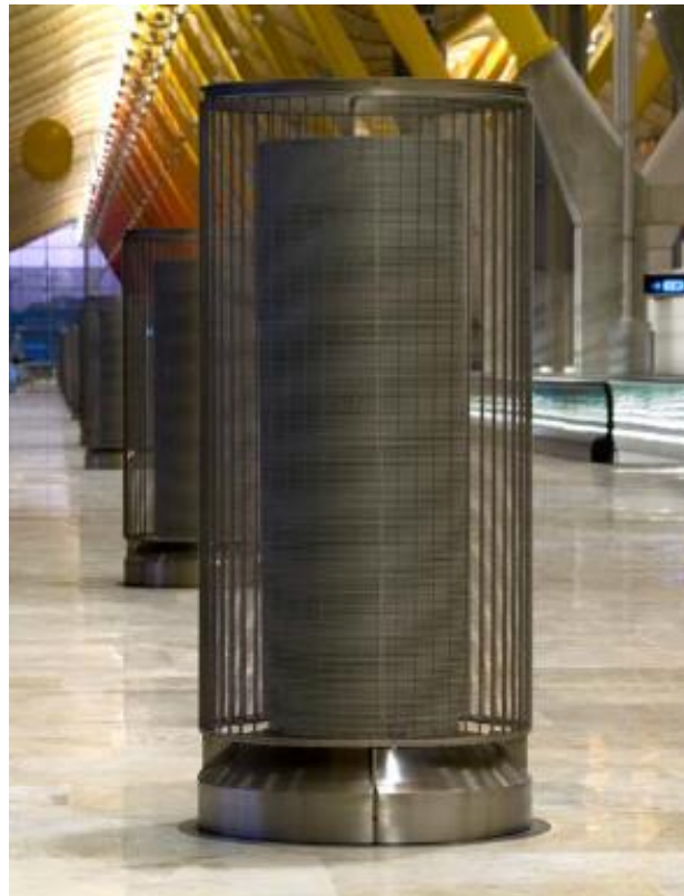
Ilustración 62. Difusor. Impulsión aire limpio
