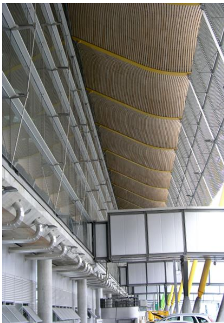
Ilustración 67. Imagen exterior Sistema Perimetral de Climatización
