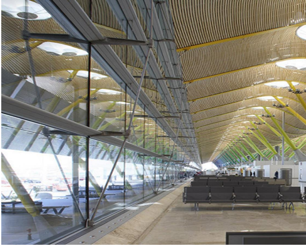
Ilustración 64. Sistema perimetral de climatización. Toberas
