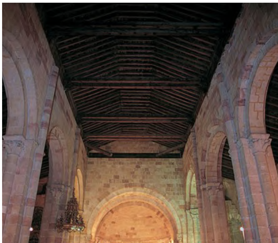
Figura 4.18: Cubierta de madera de San Andrés de Ávila.
