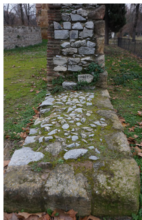
Figura 4.15: Fotografía de las capas de los muros y los cimientos de las Ruinas de San Isidoro en el Retiro, 2024.
