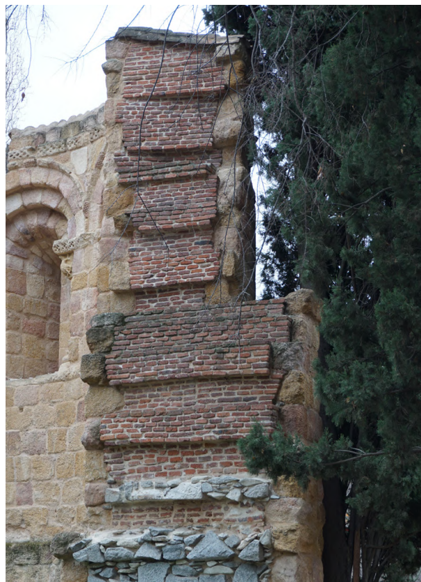
Figura 4.13: Fotografía de las capas del muro de la Portada Sur de las Ruinas de San Isidoro en el Retiro, 2024.
