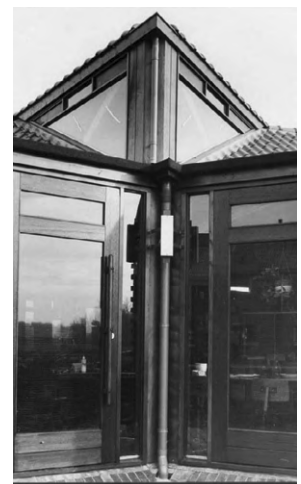
Figura 3.75. Acceso individual a un aula, donde se puede observar la forma de ocultarse ante el resto de aulas.
