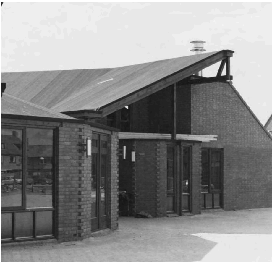
Figura 3.74. Acceso general en el centro del edificio, con el recoveco en el que se sitúa uno de los accesos laterales (izquierda).
