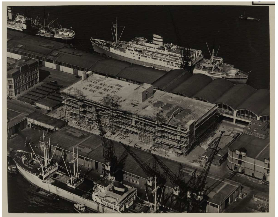
Fig 75. 1951 Toma aérea de un nuevo almacén en construcción de Holland America Line (HAL) en Wilhelminapier y, a la derecha, el almacén Pakhuismeestereen .
