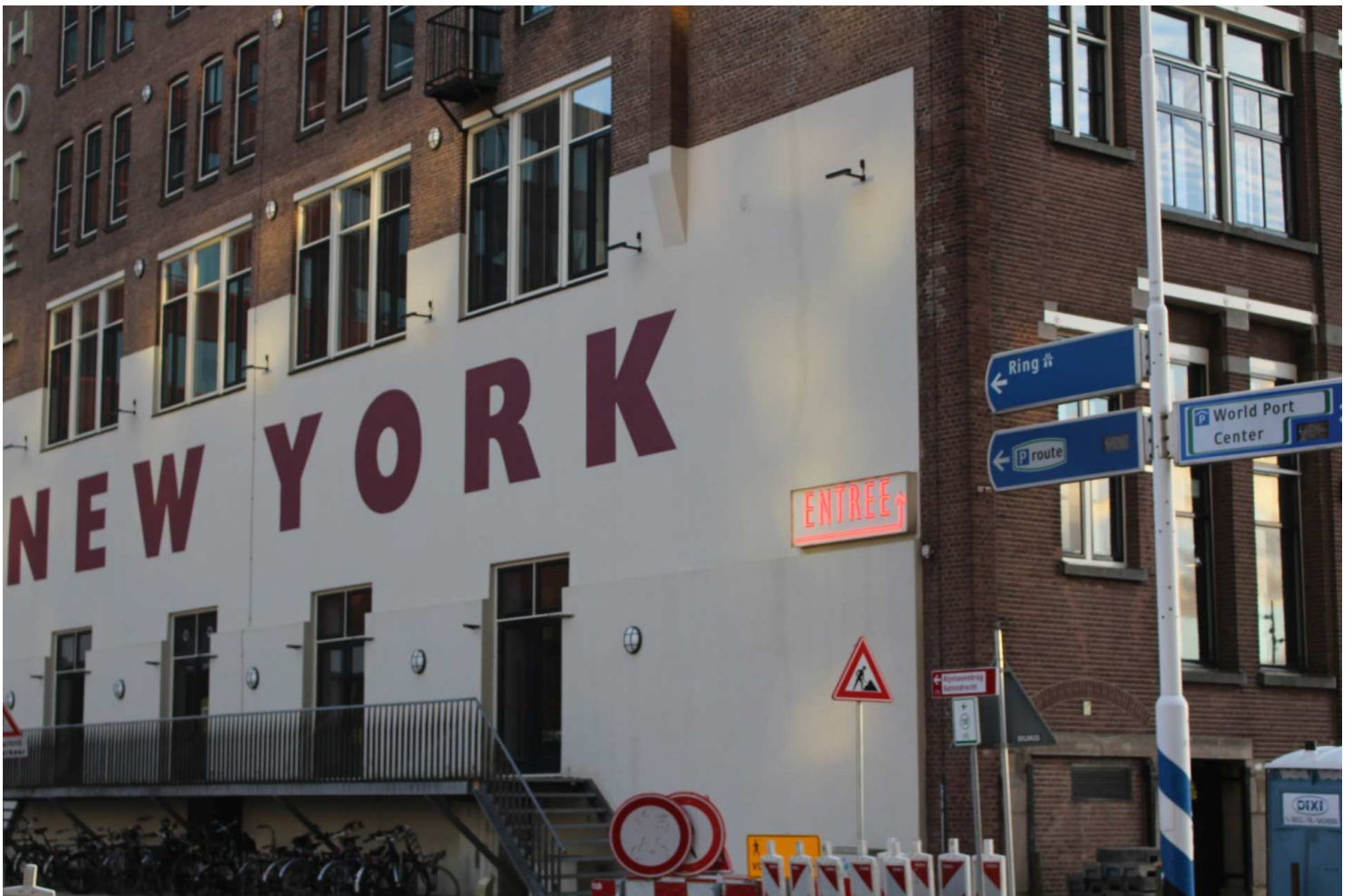
Fig 10. Fachada posterior este del Hotel New York en Wilhelminaper. Fotografía tomada por el autor.
