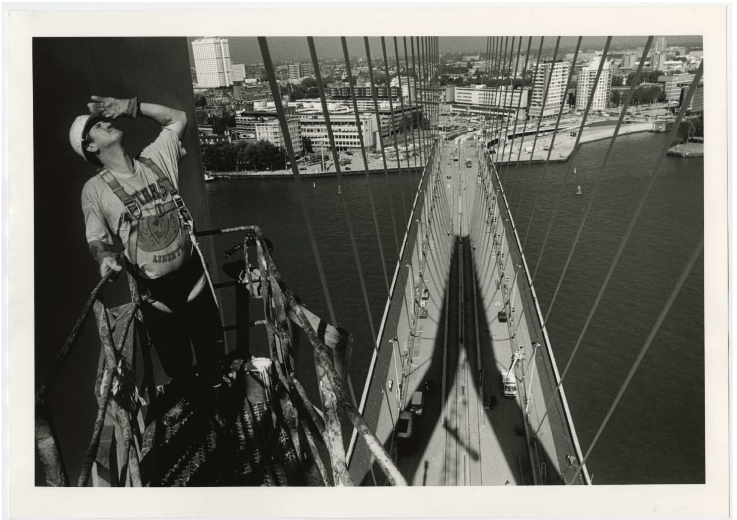
Fig 94. La construcción del Puente Erasmus. Imágenes de un reportaje fotográfico de Hajo Piebenga, 1995/1996
