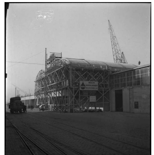
Fig 69. 1948 La Sala de Llegadas de la HAL en construcción.
