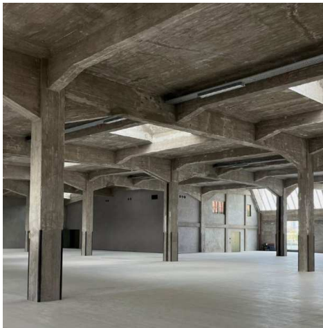
Fig 66. Interior del antiguo almacén San Francisco recién restaurado, en el barrio de Katendrecht .
