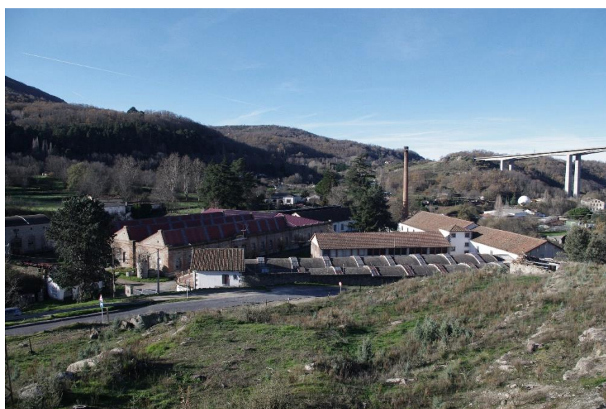
Fig. 19. Fábrica Gómez-Rodulfo. Vista de pájaro. Actual.
