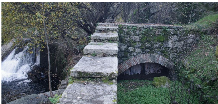
Fig. 12. Fábrica Gómez-Rodulfo. Dique y compuerta para la entrada del agua del río.
