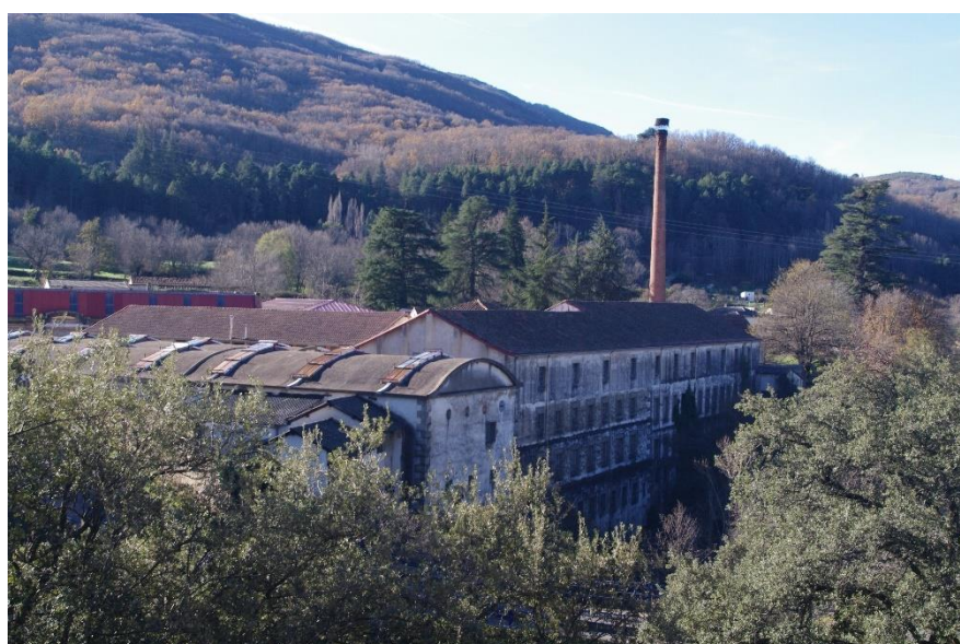
Fig. 20. Fábrica Gómez-Rodulfo. Vista de pájaro. Actual.
