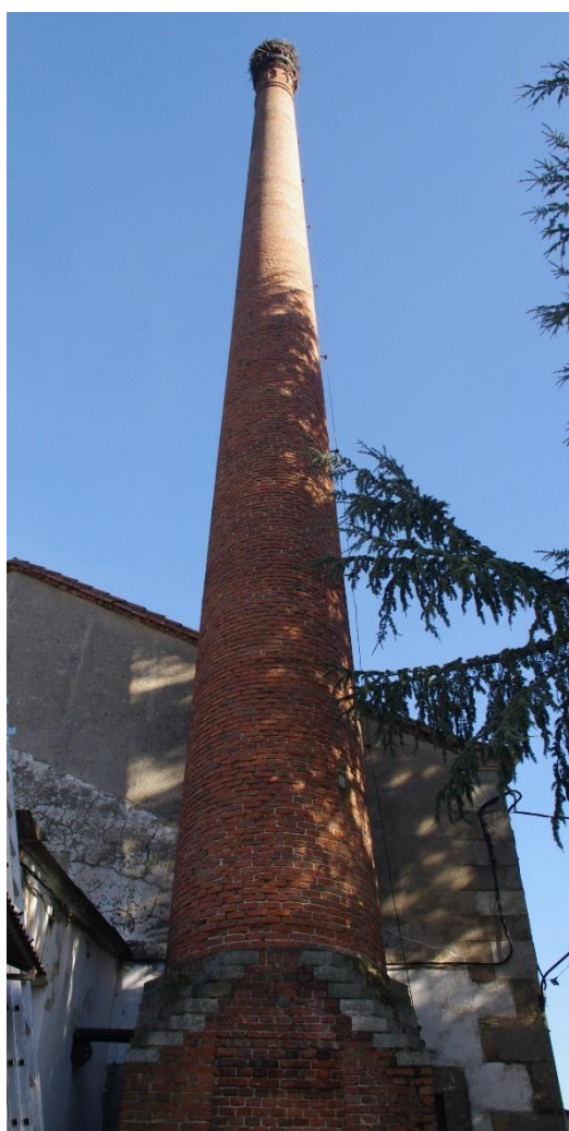
Fig. 23. Chimenea de la fábrica
