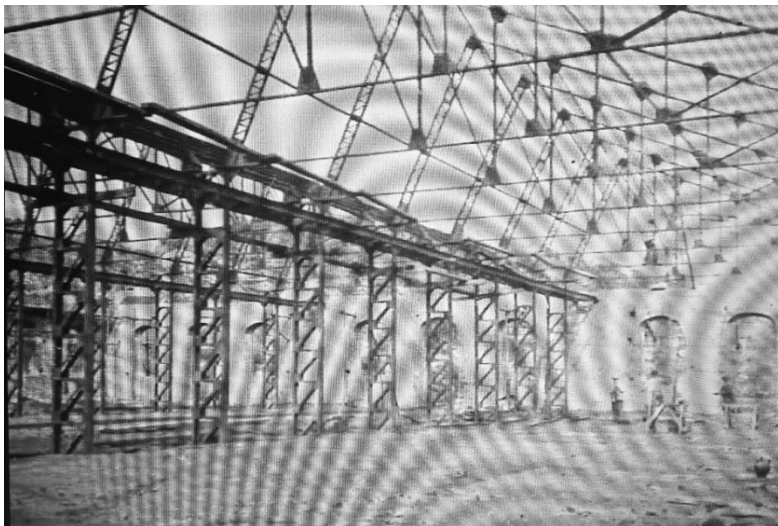
Fig. 51. Edificio 'Dientes de sierra' – Tejido e hilados. Imagen interior con la estructura construida.
