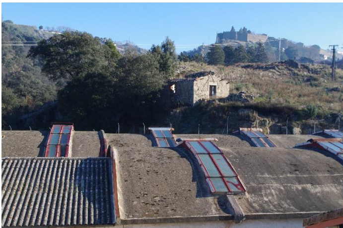
Fig. 36. Edificio industrial-hilaturas. Cubierta curva de hormigón.
