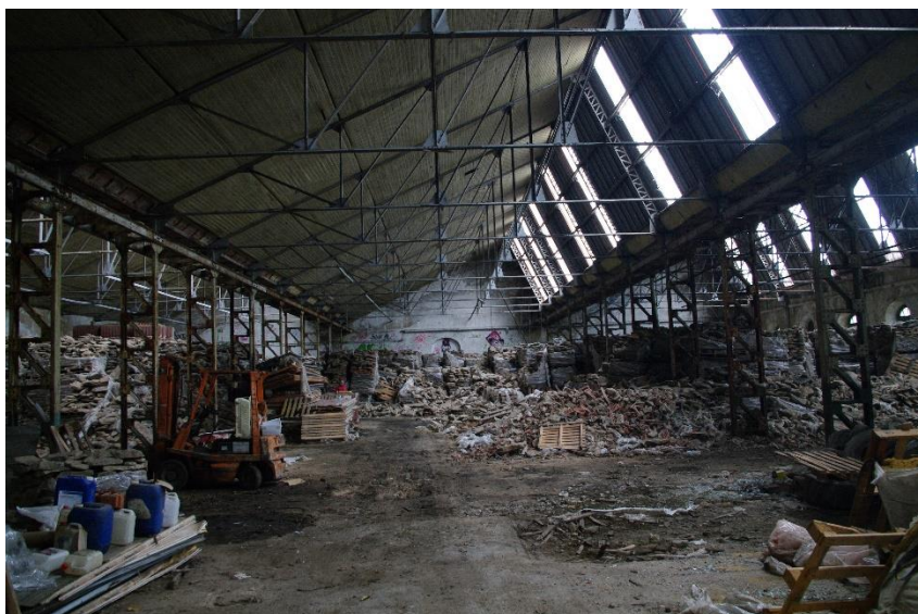
Fig. 46. Edificio 'Dientes de sierra'. Vista interior de la nave.
