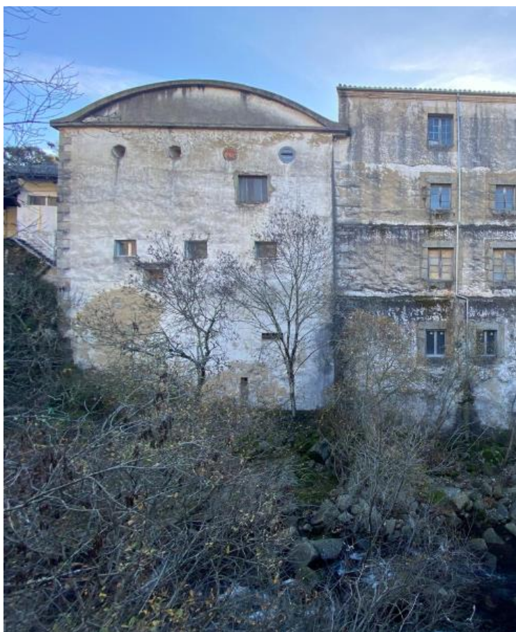
Fig. 33. Edificio industrial - hilaturas. Fachada al río.
