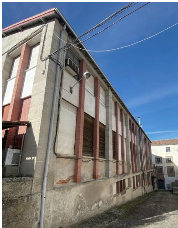
Fig. 32. Fachadas del Edificio de despacho y oficinas.
