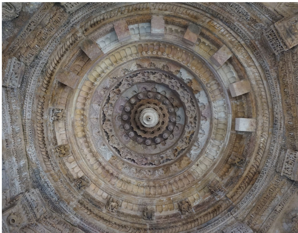
[Fig. 18] Templo del Sol, Modhera, Gujarat. Elaboración propia.
