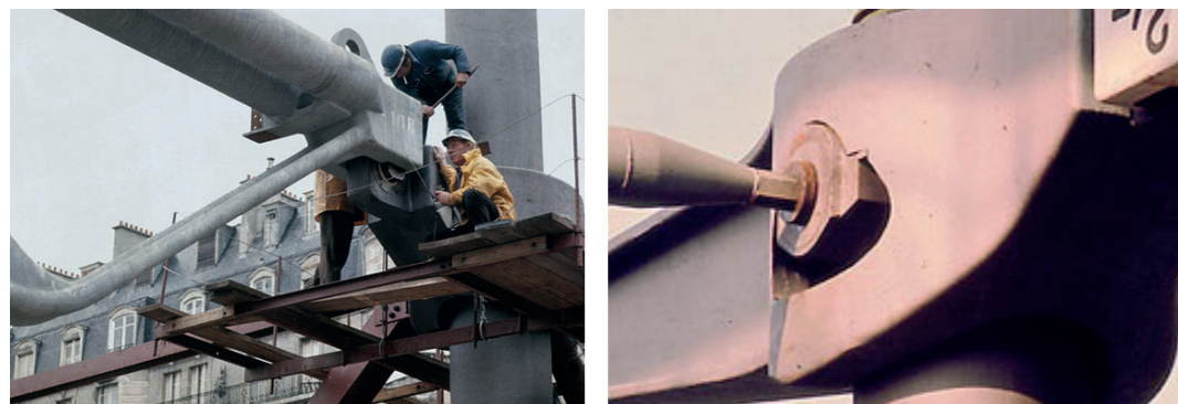
Figura 51. Montaje de las cerchas. Adaptado de Fixation d'une poutre à une gerberette [Fotografía], por Mediation Centre Pompidou, s.f.
