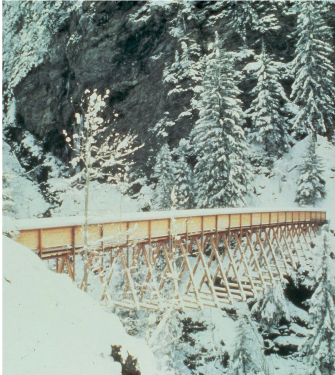
Figura 1. 1st Traversina bridge, Jürg Conzett. Adaptado de Traversinersteg [Fotografía] por Kruh, 2023.
