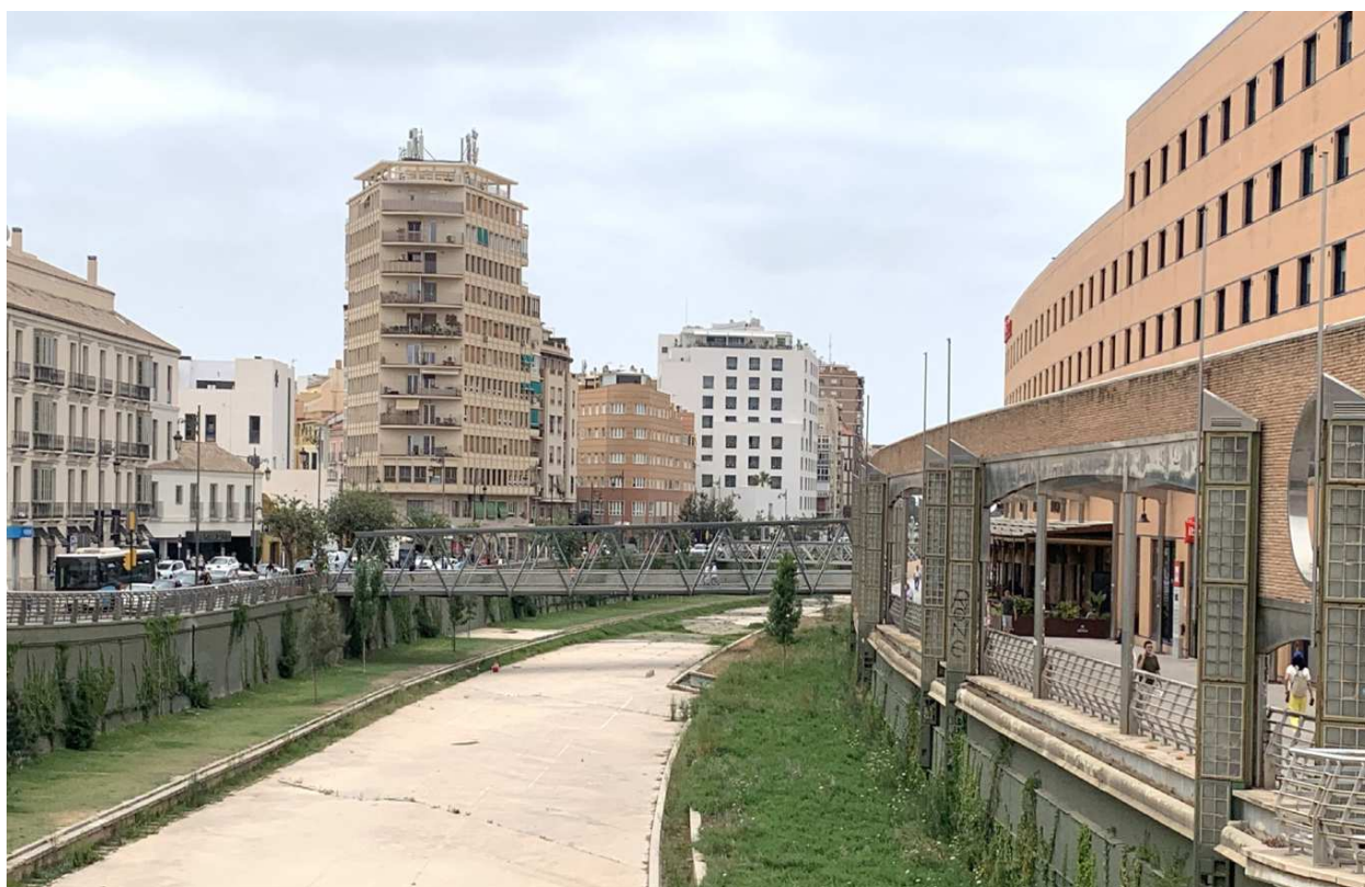
Figura 12. El río Guadalmedina en su estado artificial, Puente de la Aurora, vista hacia el sur Fotografía del autor, agosto de 2024
