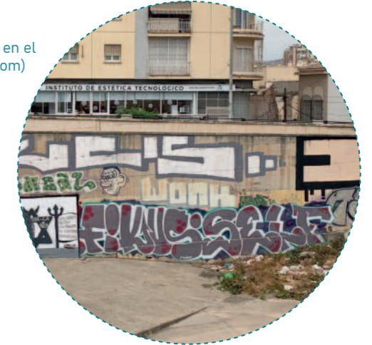
3. Lecho de hormigón del Guadalmedina
