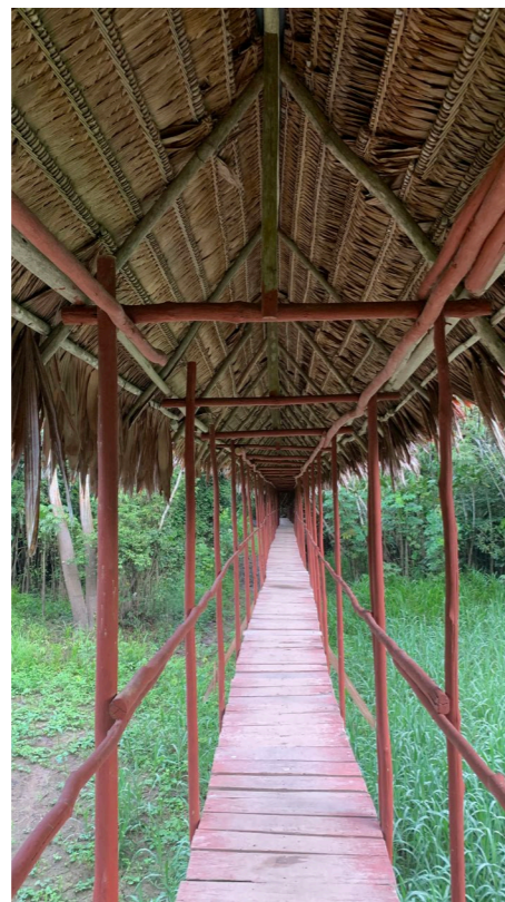
Ilustración 14: pasarelas sobre pilotes. Fuente: elaboración propia.
