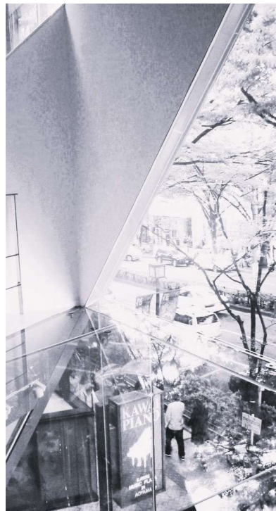
Fig. 115 Encuentro de fachada con techo de la entrada principal de Tod's Omotesando. Toyo Ito 2002-2004.
