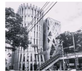
Fig. 92 Edificio de Tod's y Boss desde la calle.
