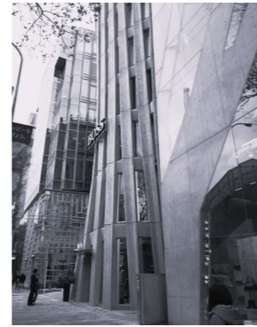
Fig. 94 Vista desde la acera. Encuentro con el edificio de Boss.
