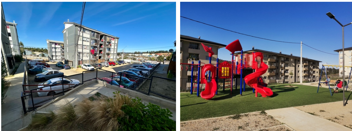
Figura 7-11 Plazas interiores Conjuntos Habitacionales DS.19 (izquierda) y DS.49 (derecho)
