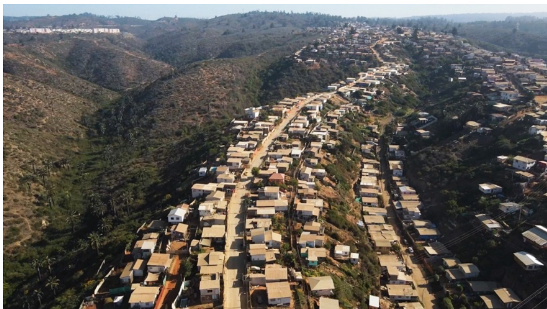
Figura 8-17 Asentamientos lineal de las viviendas en la cima campamento Felipe Camiroaga
