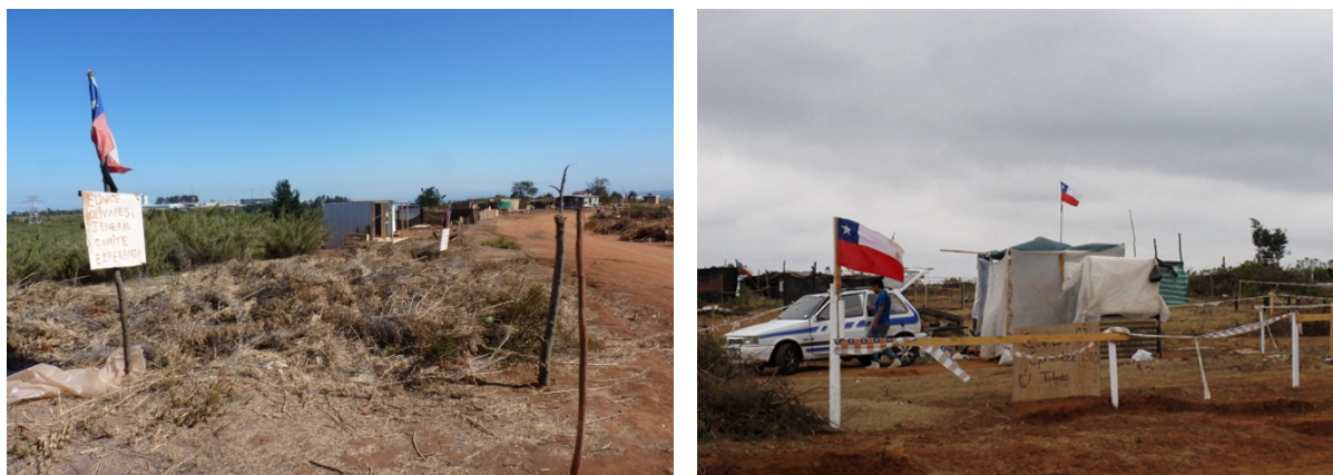
Figura 8-7 Proceso de trazado y estacado de los terrenos Campamento Felipe Camiroaga
