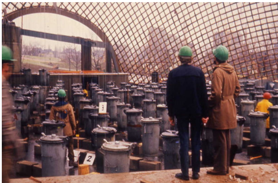
[Fig. 1.07] Prueba de carga en la estructura construida del Multihalle Mannheim.
