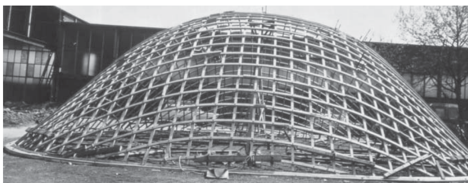
[Fig. 1.02] Estructura de prueba en Essen.
