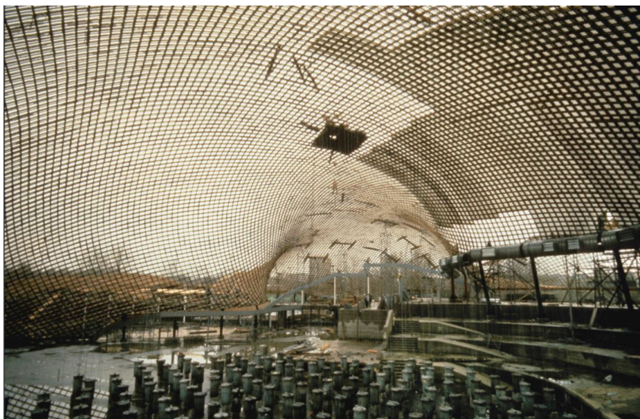
[Fig. 0.07] Prueba de carga en la estructura final. Mannheim Multihalle.
