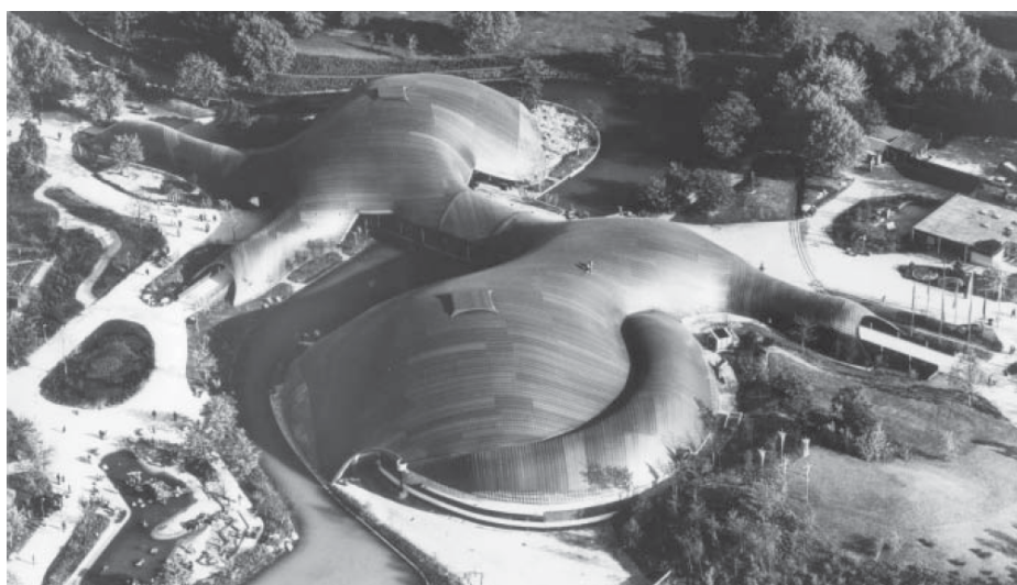
[Fig. 1.05] Vista aérea del Multihalle completado.
