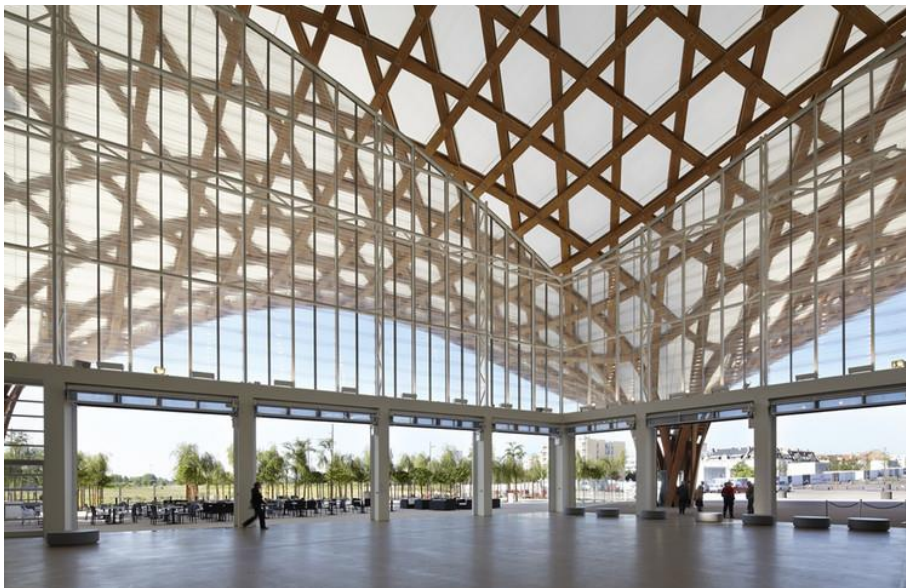
IMAGEN 2.7. Centre Pompidou Metz (Shigeru Ban)
