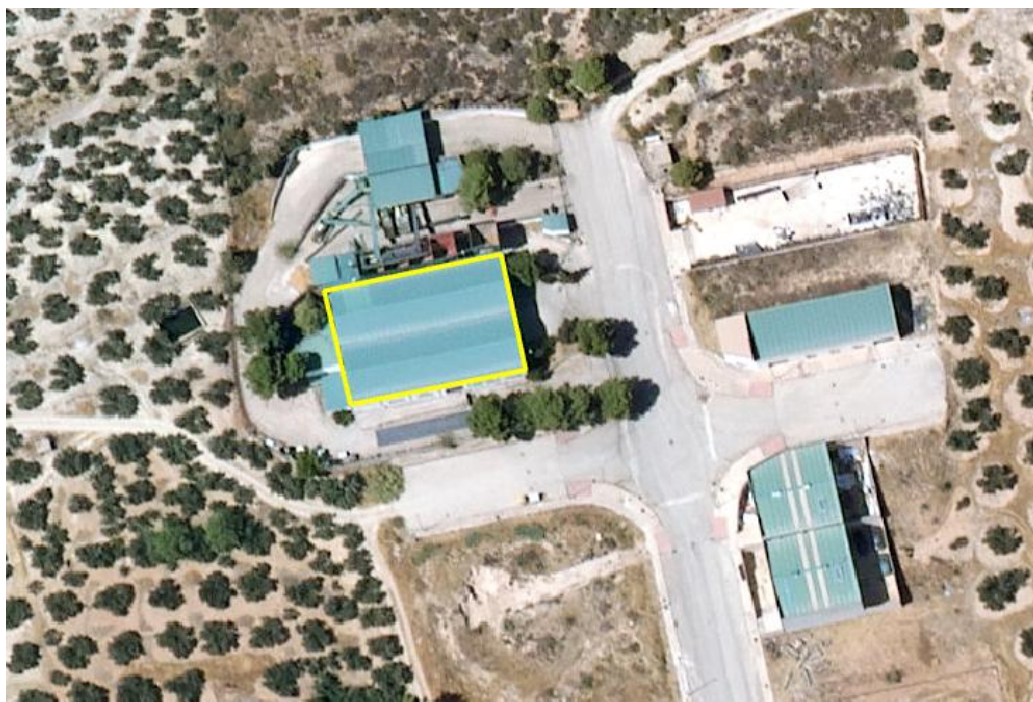
Ilustración 2: Cubierta de la almazara donde se instalan los módulos fotovoltaicos. Fuente: SIGPAC
