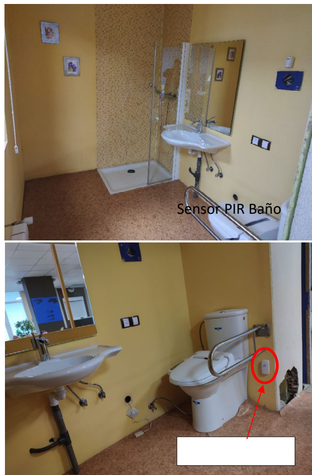
Figura 18: Instalación de sensor PIR del baño en el HDA
