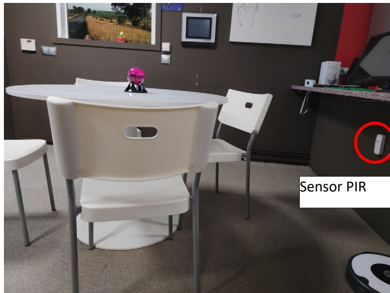
Figura 20: Instalación de sensor PIR del comedor en el HDA
