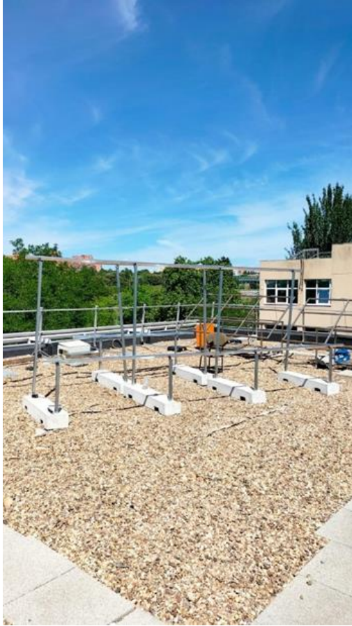
Figura 33. Estructura fija con inclinación de 40°
