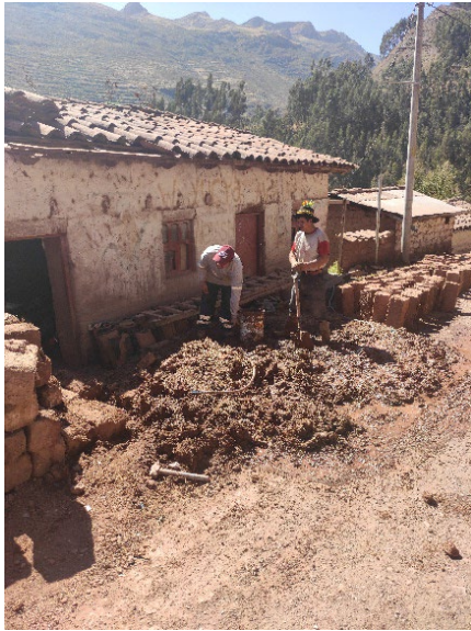
Figura 2. Escenas de autoconstrucción de viviendas de adobe. Los bloques de adobe se elaboran con medios rudimentarios y se apilan (izquierda). Se suelen emplear hormigones pobres para las cimentaciones (derecha).
