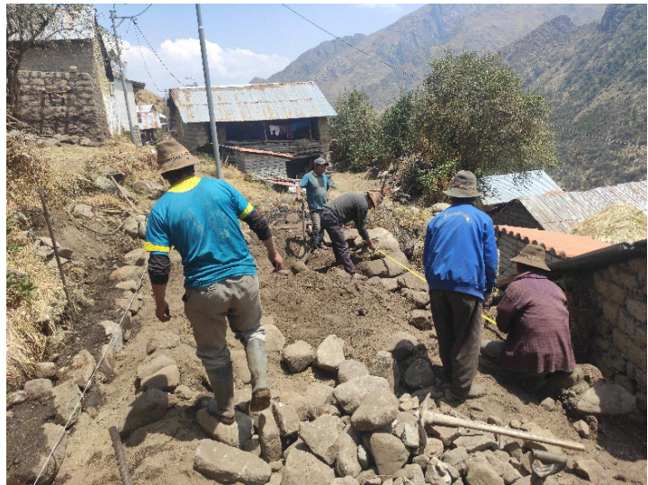
Figura 2. Escenas de autoconstrucción de viviendas de adobe. Los bloques de adobe se elaboran con medios rudimentarios y se apilan (izquierda). Se suelen emplear hormigones pobres para las cimentaciones (derecha).
