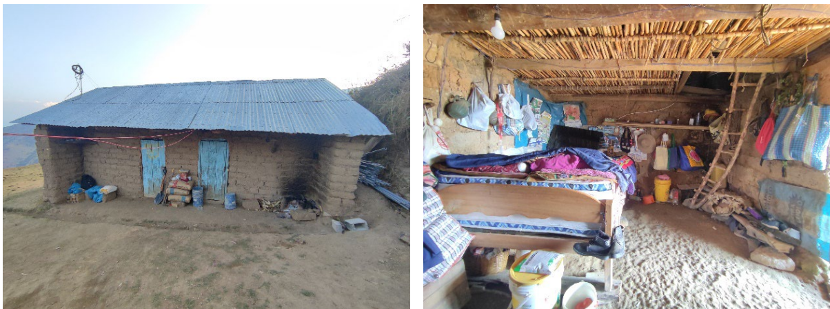
Figura 1. Vivienda típica de mampostería de adobe (izquierda) y detalle de las condiciones de habitabilidad (derecha): estancia única, acabados y equipamientos deficientes.
