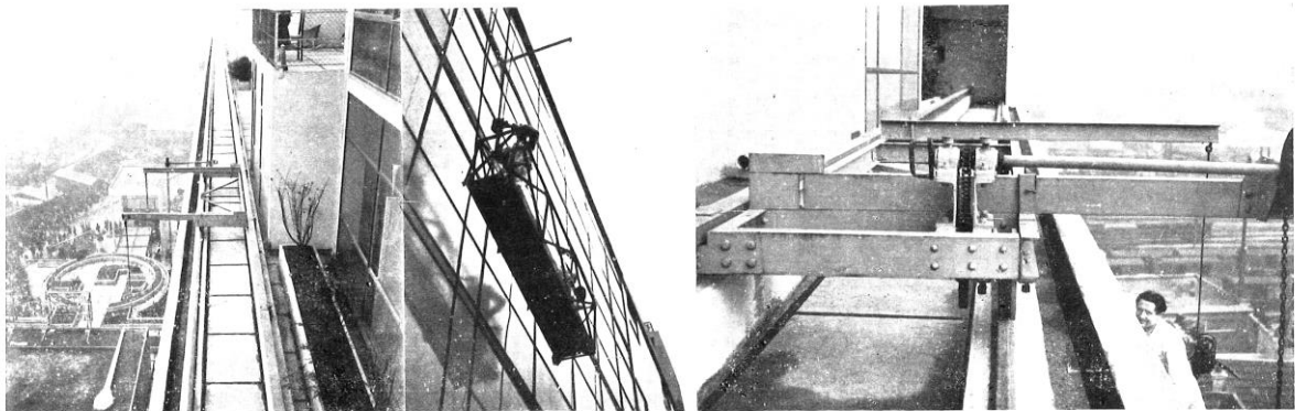
Appareil de nettoyage du pan de verre. Cet appareil d'une simplicité extrême, roulant sur deux rails, est manœuvré par un moteur. Il a servi à poser le verre, à faire la peinture, et il est employé pour l'entretien
