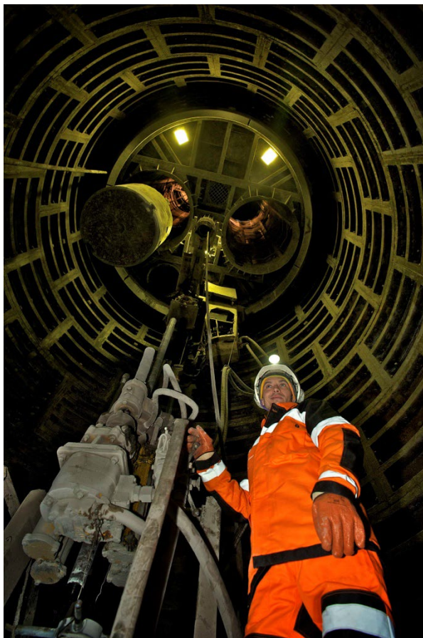
Excavación de pozo en mina de EuroChem Usolskiy Potash. (Fuente: http://www.eurochemagro.com .)
