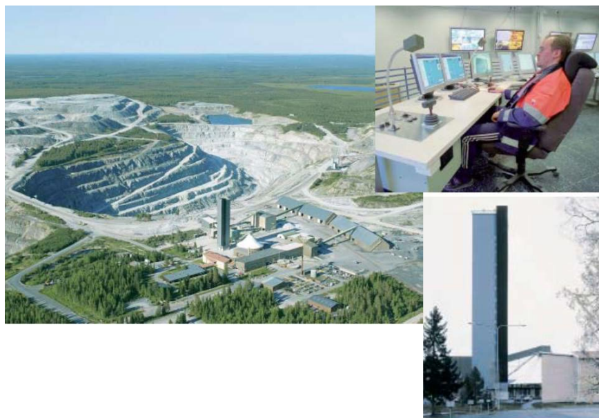
Mina Kemi (Outokumpu) y detalle de la sala de control de la operación del pozo (Fuente: ABB).
