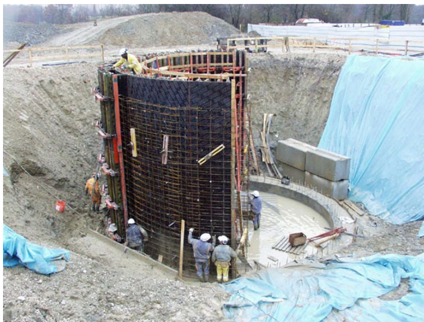
Construcción de embocadura de un pozo.
