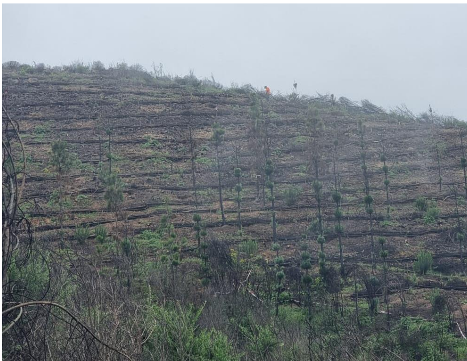
Imagen n.º 1. Ejemplo sobre la elaboración de fajinas sobre pendientes entre 40-60%. Elaboración propia.
