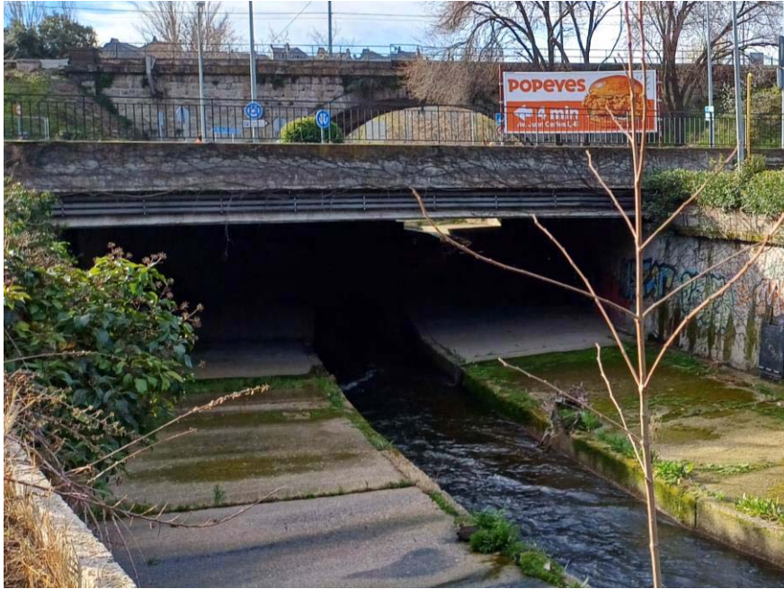
Ilustración 16. Tramo canalizado que transcurre por debajo de una glorieta. Fuente: Fotografías propias.
