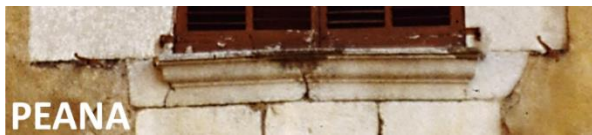
[09] Flujos en torno al hueco dintel y peana rotos. Girona
