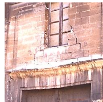
[15] Montpellier. Dintel deformado
