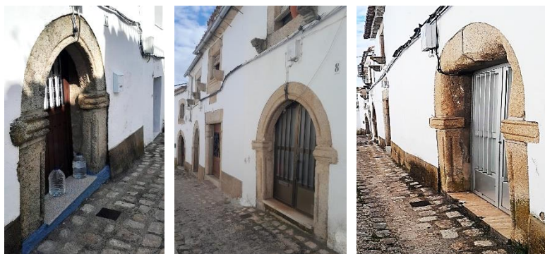
Valencia de Alcántara, [55] portadas [56] que no fisuran (Pilar Ávila Medrano)
