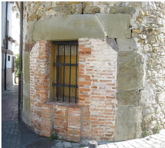
[46] Ampuero. Dintel de planta curva en un chaflán
