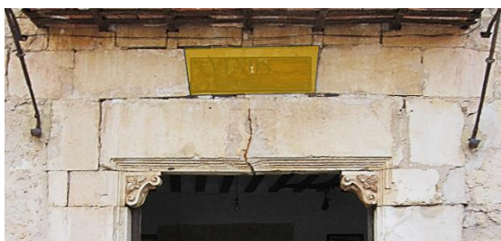
[24] Pedraza, portada con dintel acuñaado y roto
