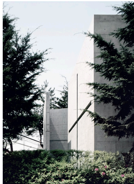
3.2. Capilla de la Luz. Cruz metálica en fachada exterior. AV Monografías 241-242, Tadao Ando.
