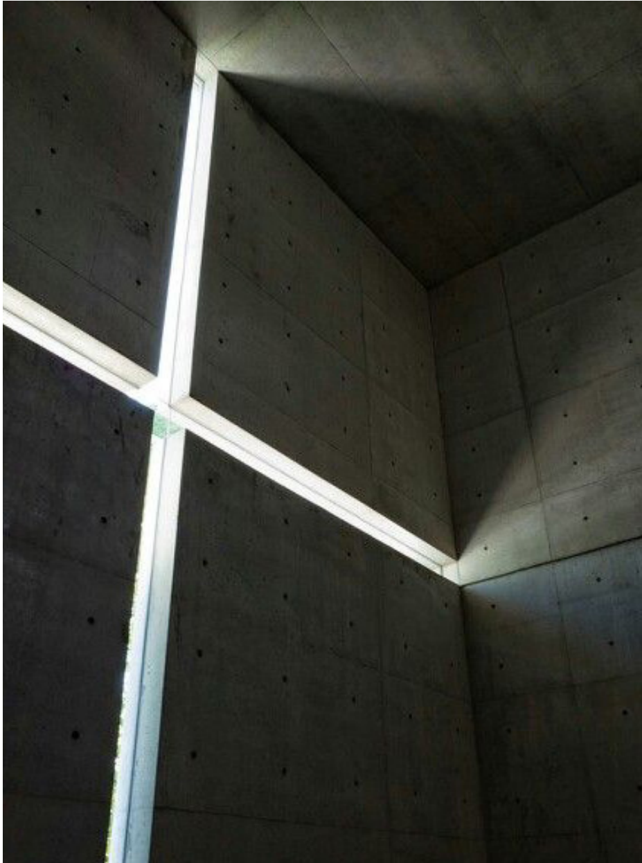
3.8. Capilla de la Luz. Interacción de la luz con el hormigón de los muros.
