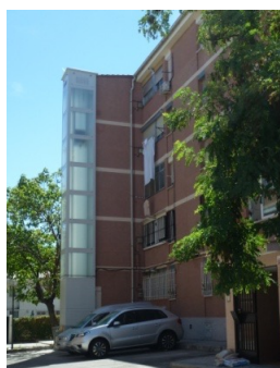
P.D. Manoteras. Instalación de ascensor anejo. VCB-T5, 2012 (Fotografía de la autora)
