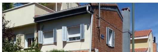
P.D. Manoteras. Modulación de ventana VU-S2. 2012 (Fotografía: autora) (Fuente: Revista Hogar y arquitectura , 62, 1966, 13)
