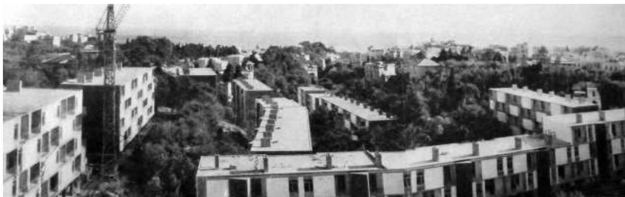
Figura 2. Quartiere di villa Bernabò Brea
