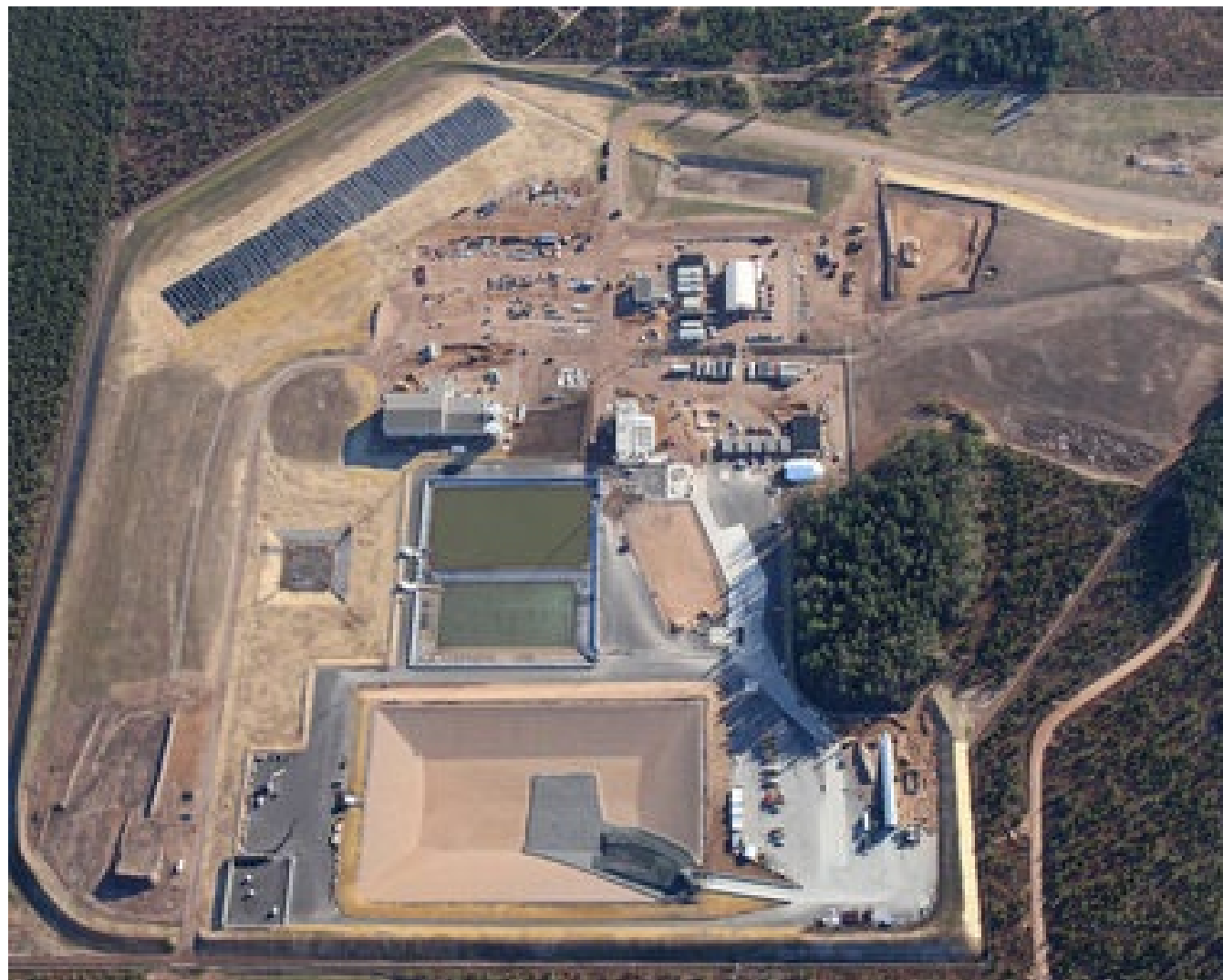
Rio Tinto Eagle Mine. Vista de infraestructura de superficie
