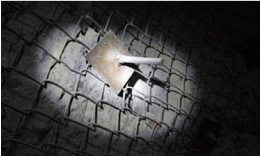
Perno instalado.
