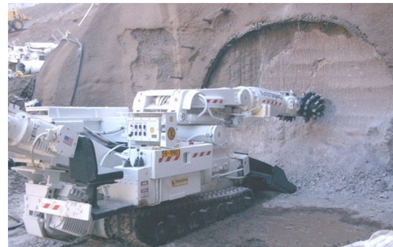
Arranque mecánico (minador)
