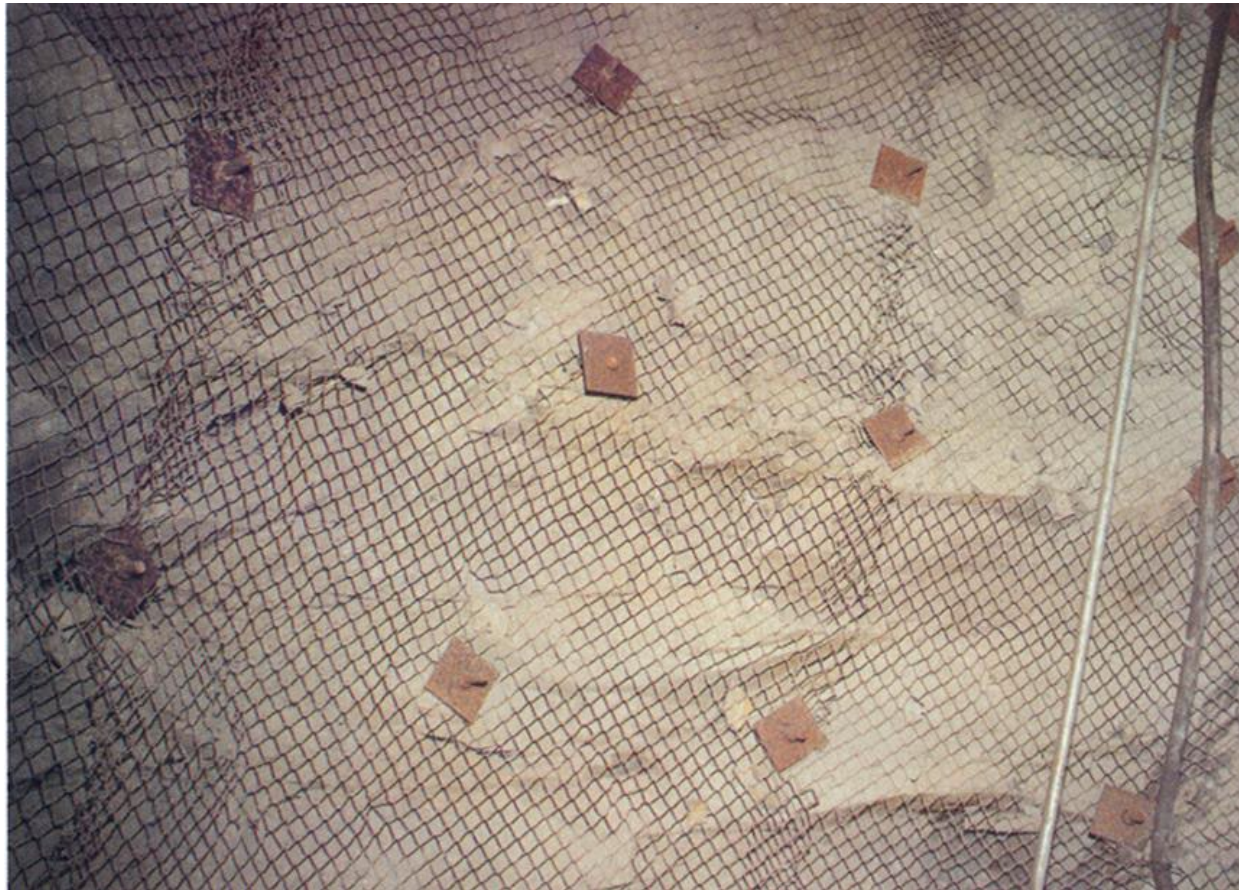
BULONADO SISTEMÁTICO CON MALLA METÁLICA
