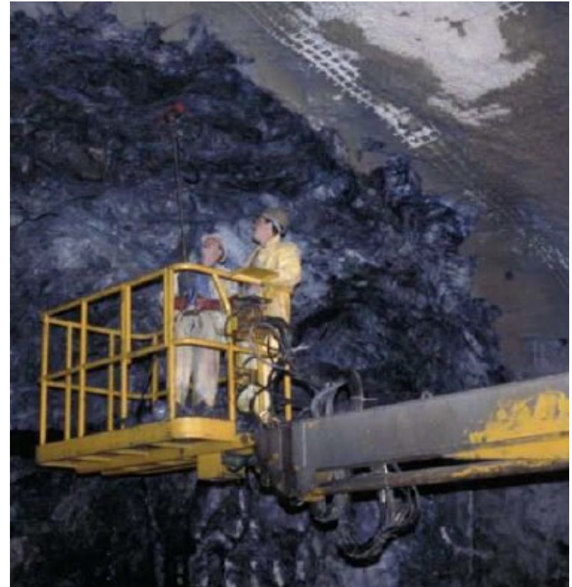
PERFORACIÓN CON JUMBO E INSTALACIÓN MANUAL
