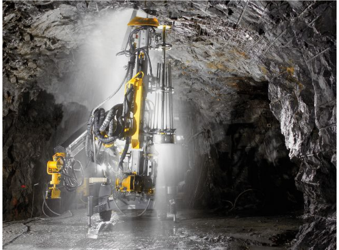
MECANIZADA CON BULONADORA
