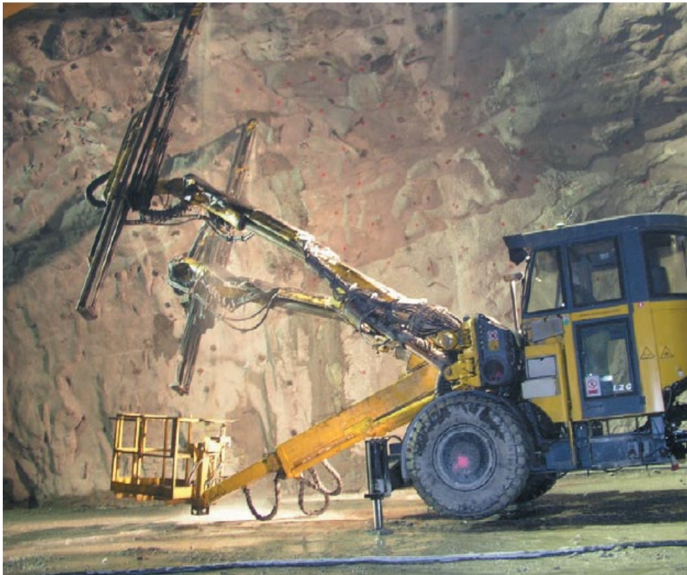
PERFORACIÓN CON JUMBO E INSTALACIÓN MANUAL
