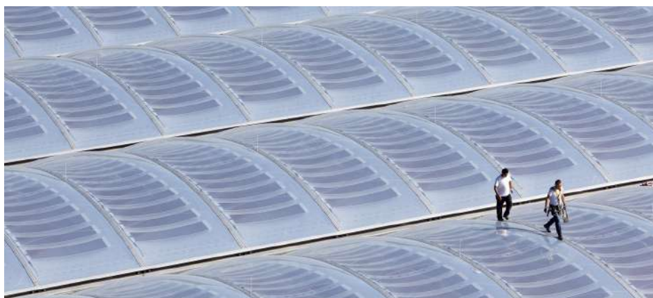
[Fig. 06] Cubierta de la cochera de AWM, Múnich.
