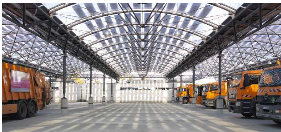
[Fig. 07] Interior de la cochera de AWM, Múnich.
