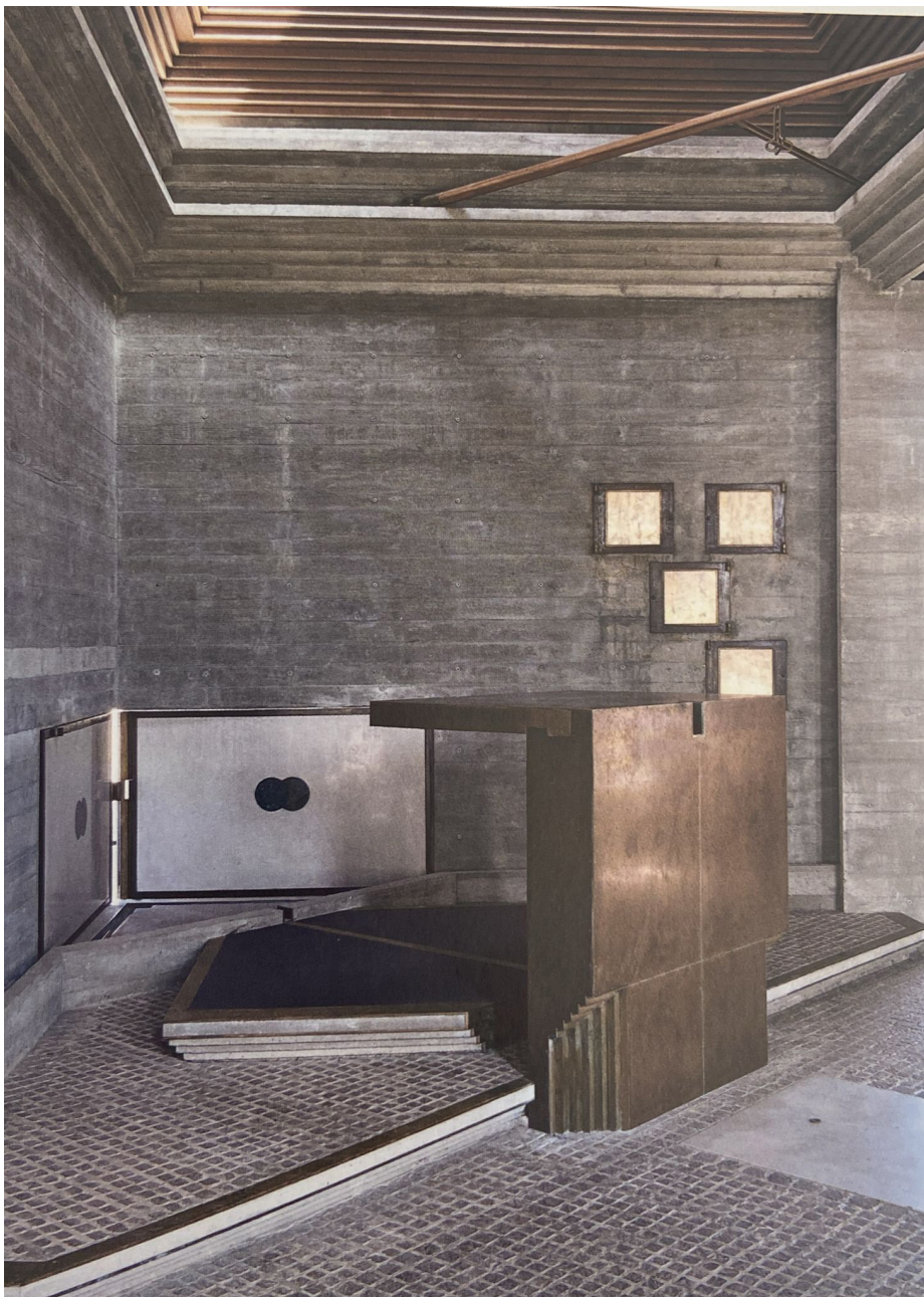
Fig. 64. Detalle de la escalera interior. Libro: Carlo Scarpa. Electa . 1906-1978.
