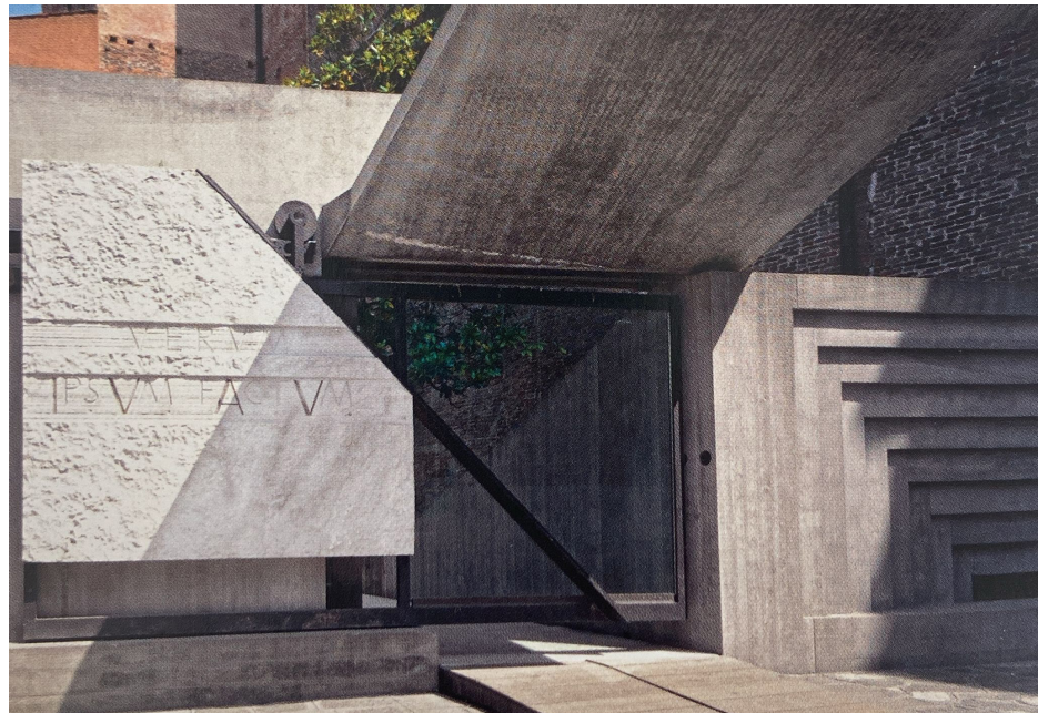
Fig. 55. Vista del nuevo acceso hacia el campus de la universidad con la puerta corredera cerrada. Universidad de Venecia. Libro Segio Los.
