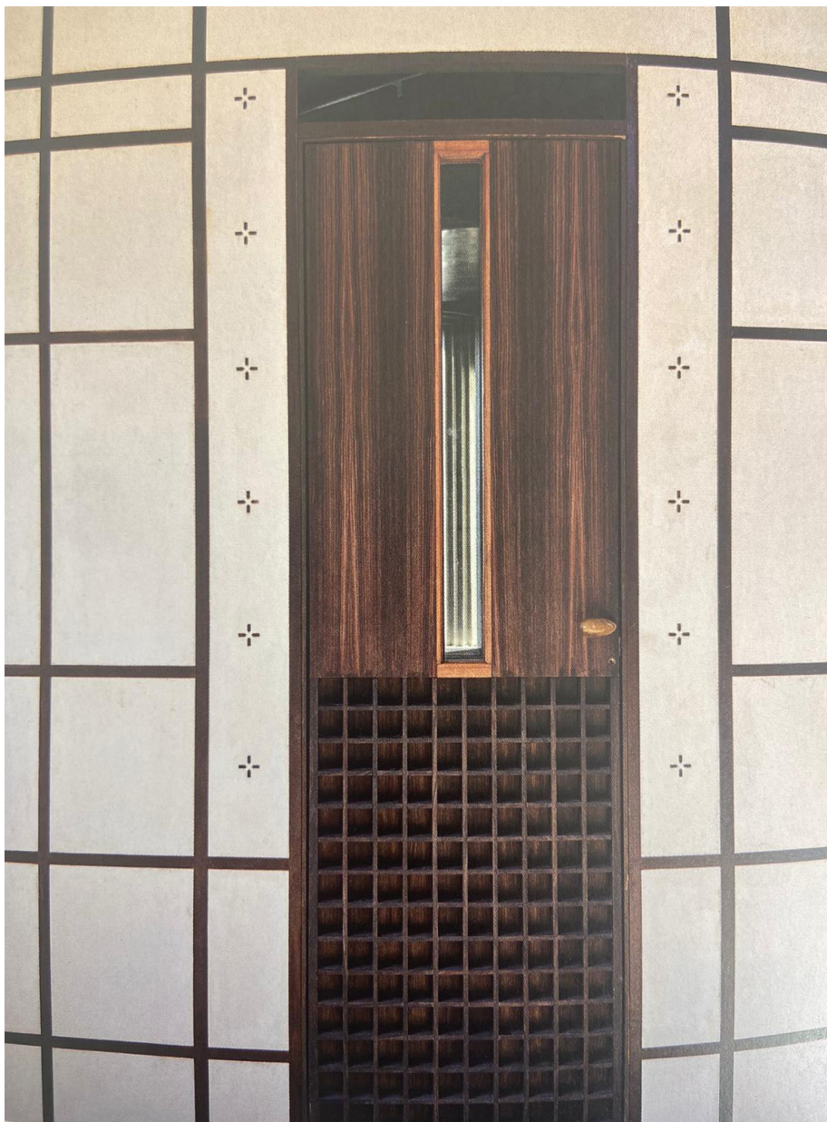
Fig. 48. La doble apertura que introduce al tempietto: la puerta central en ébano y, al lado, la puerta móvil giratoria sobre rodillos. Libro: Carlo Scarpa. Oltre la materia.
