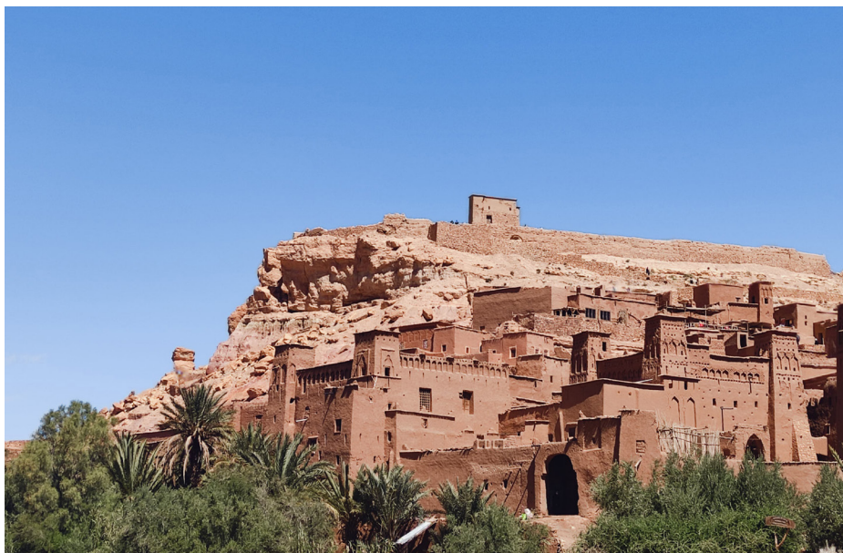
2.13. Imagen del Ksar de Ait Ben Hadu (Fotografía de elaboración propia)
