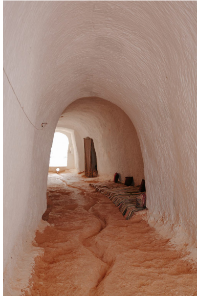
2.10. Túnel de entrada con canal de recogida de agua (izquierda).
