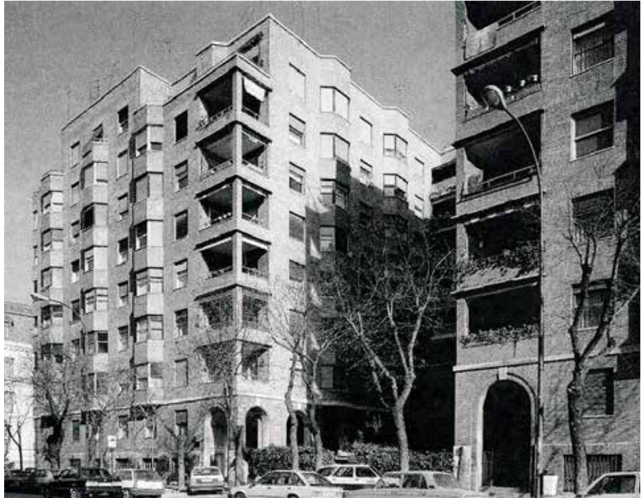
2.4. Estado de las terrazas en esquina de Miguel Ángel nº4-6.
