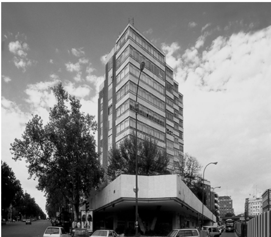
2.12. Cerramiento de las terrazas del edificio de la calle Velázquez c/v López de Hoyos, años 1980.
