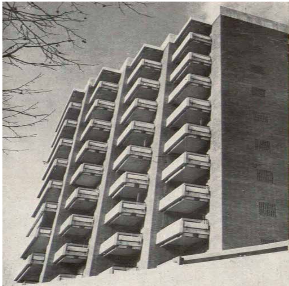
o.2. Vista exterior terrazas escalonadas edificio de viviendas en c/López de Hoyos c/v Velázquez.
