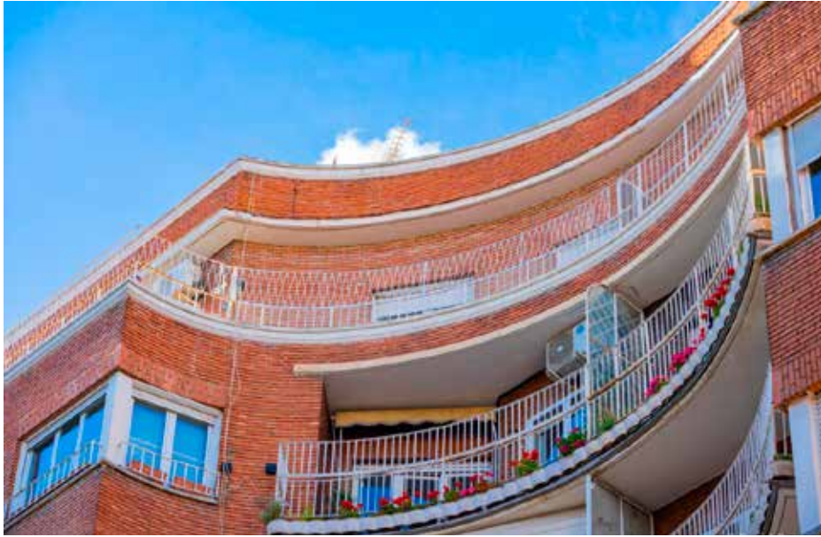
2.1. Estado actual terrazas de Bretón de los Herreros nº 57, detalele barandilla y cubre tiestos de chapa.
