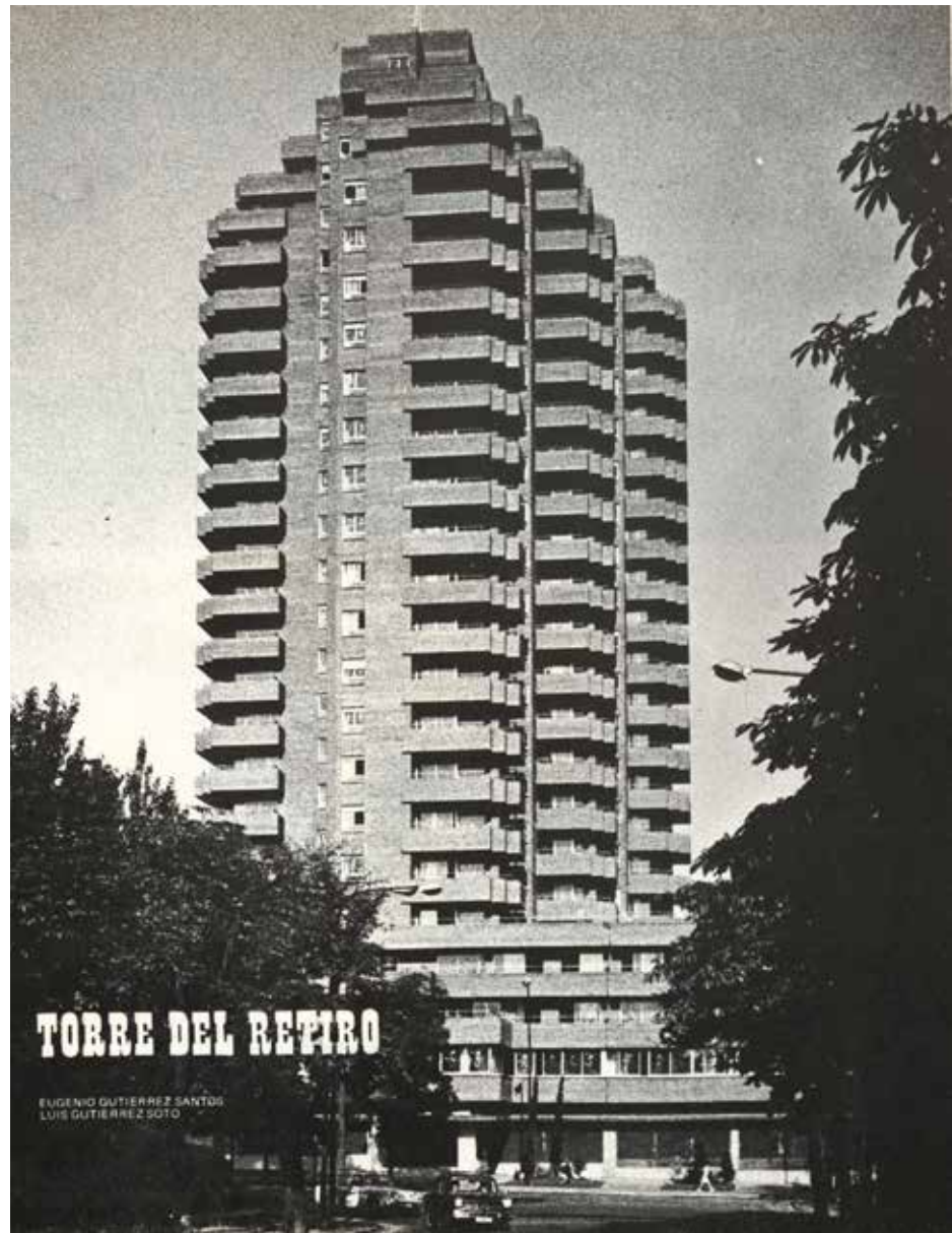
o.1. Vista de las terrazas de la Torre del Retiro
