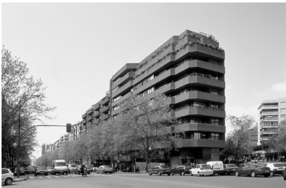
1.27. Edificio de viviendas en Paseo de San Francisco de Sales c/v Julián Romea.
