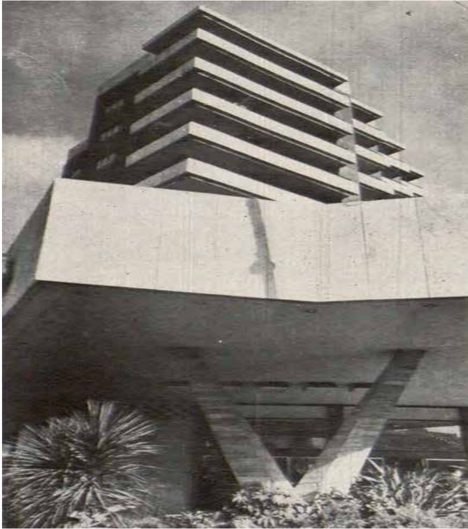
2.11. Estado original de las terrazas del edificio de la calle Velázquez c/v López de Hoyos 1963.
