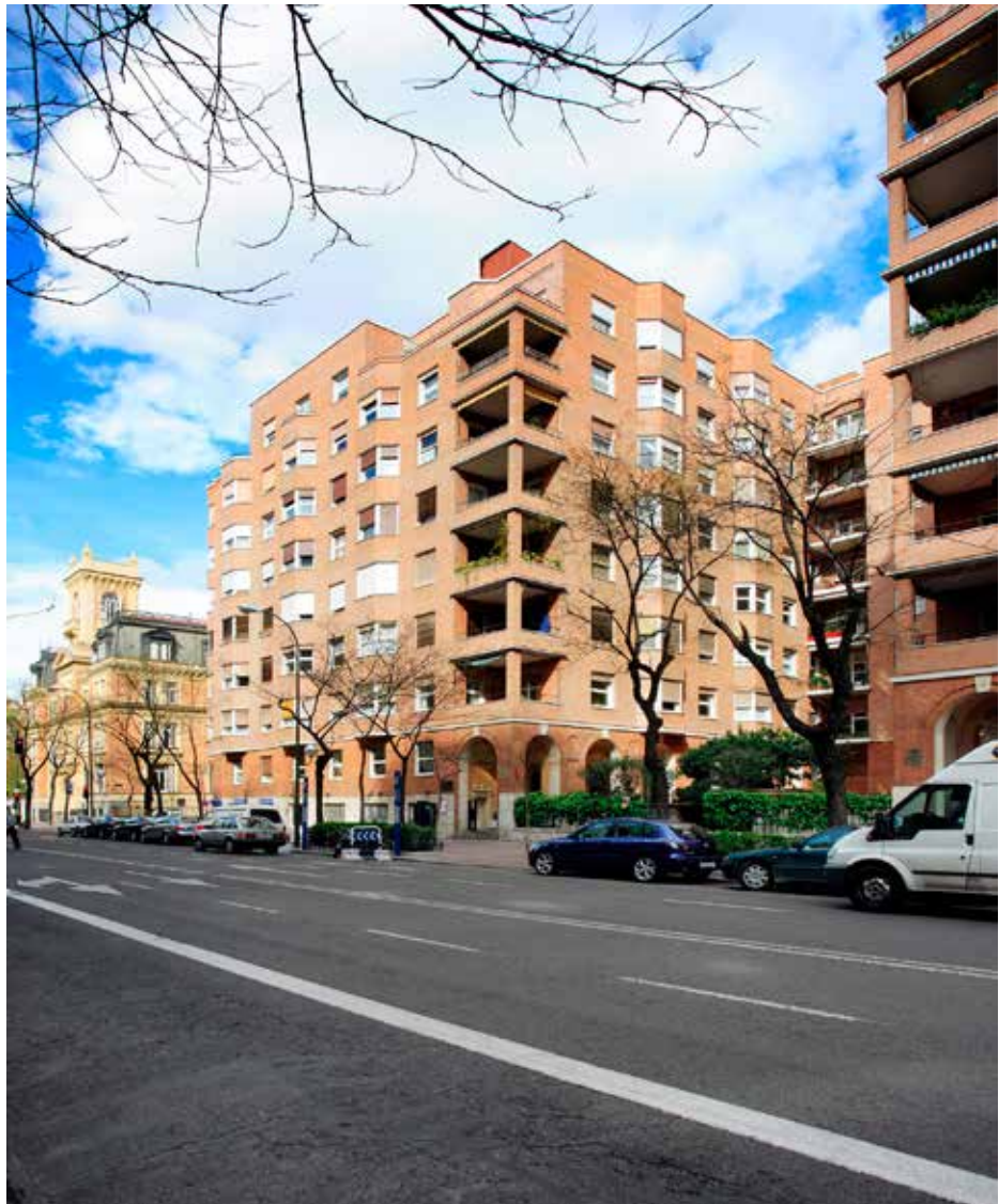
2.6. Estado actual de las terrazas de Miguel Ángel nº4-6.
