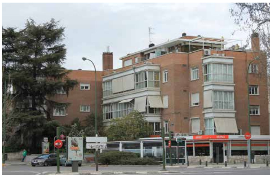
2.15. Estado actual del edificio Richmond. Vemos la inadecuada disposición de los cerramientos nuevos que hace necesario extender los toldos por completo.
