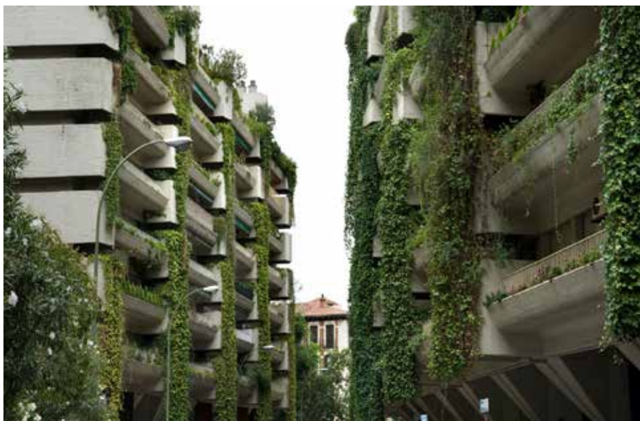
1.32. Fernando Higuera. Edificio de viviendas para el patronato militar. Detalle de las terrazas.
