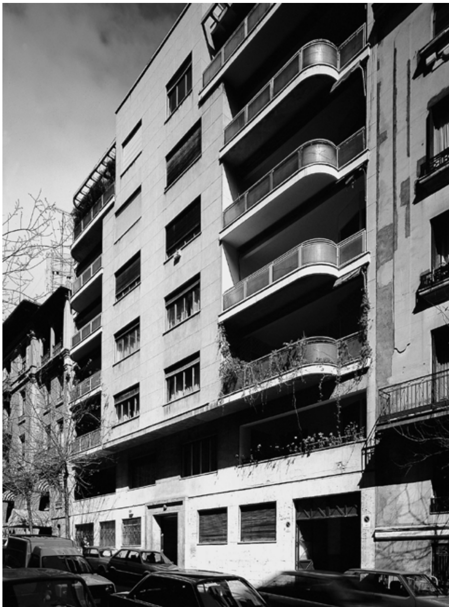
1.1. Vista terrazas en curva de la calle Zurbano nº27.
