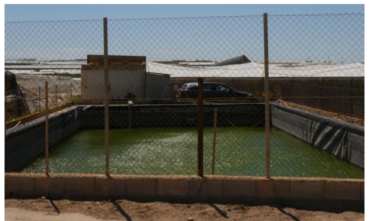
[Figura 91] Balsa de riego excavada, tipo piscina. Fuente: Elaboración propia
