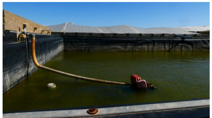
[Figura 90] Vista interior de una balsa de riego sobre cota cero del terreno. Fuente: Elaboración propia
