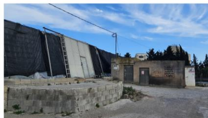
Vista exterior del invernadero
