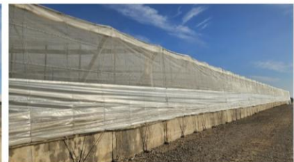
Vista exterior del invernadero
