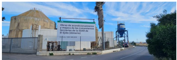
[Figura 77] Depuradora de agua EDAR El Ejido.
