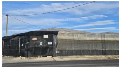
Vista exterior del invernadero
