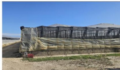
Vista exterior del invernadero
