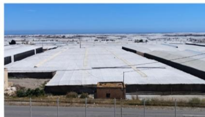
Vista exterior del invernadero
