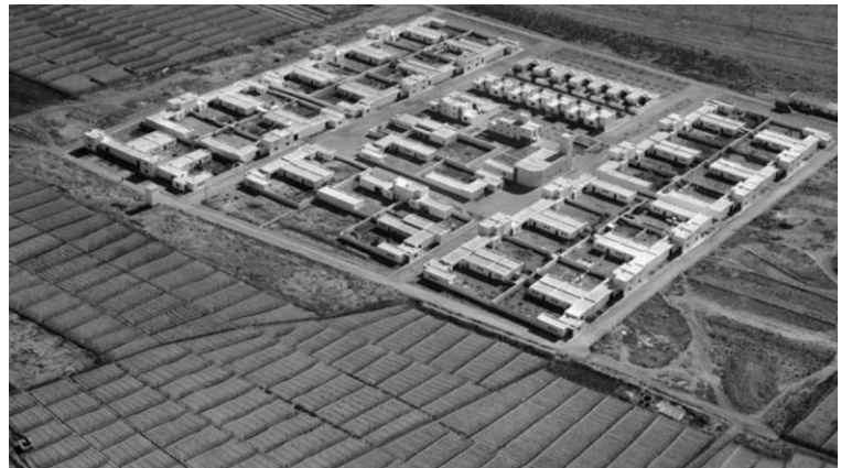
[Figura 20] Vista aérea de Las Marinas. Fuente: Ayuntamiento de Roquetas de Mar, 2025
