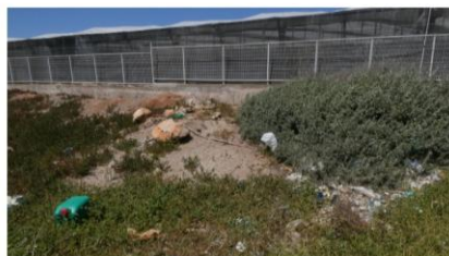
Vista exterior del invernadero
