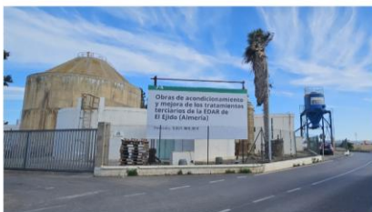
Depuradora de agua EDAR Elaboración propia
