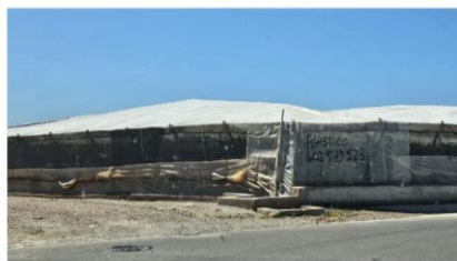
Vista exterior del invernadero
