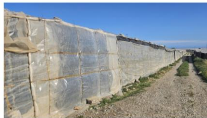
Vista exterior del invernadero
