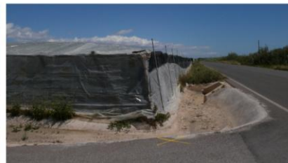
Vista exterior del invernadero
