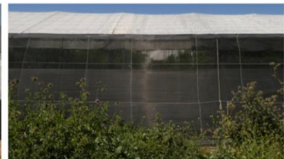
Vista exterior del invernadero
