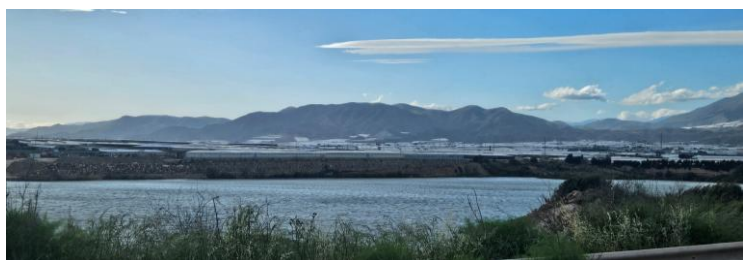
[Figura 78] Vista de la gran balsa de agua situada junto a la depuradora de agua EDAR El Ejido.
