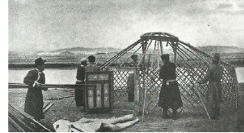
Figura 2. Construcción de una yurta en Asia central.
