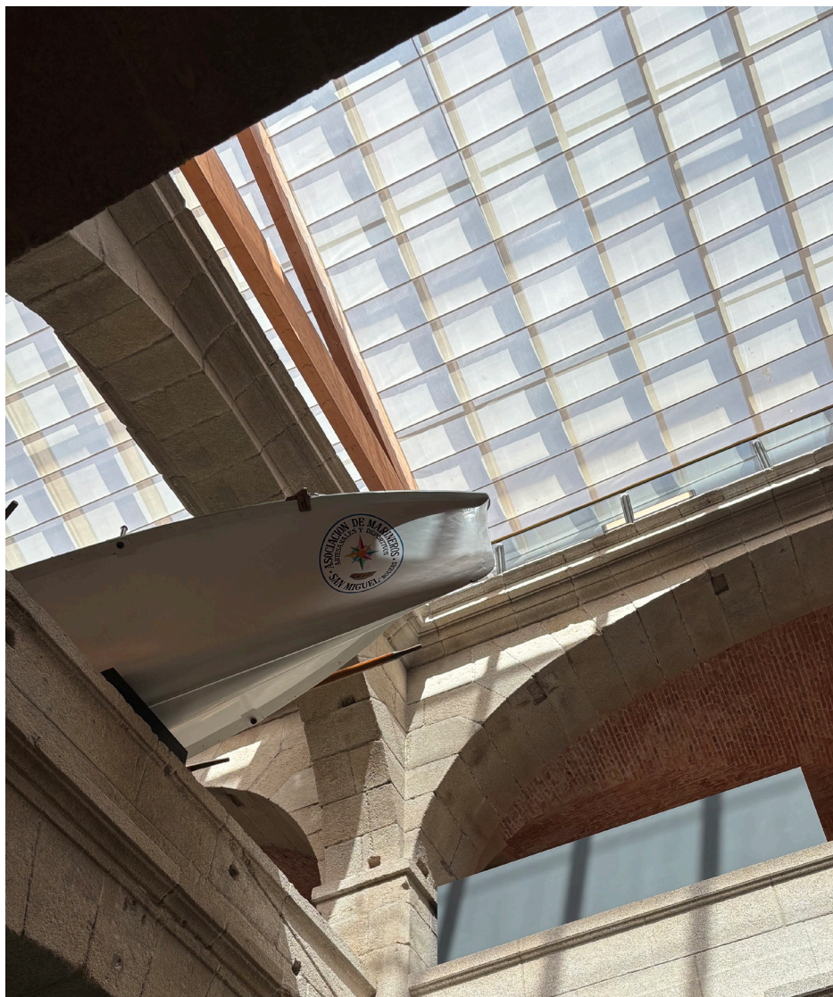
2.3.12 Imagen del lucernario del edificio Las Herrerías (2025)
