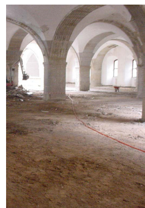
2.3.26 Imagen de la primera planta en obras. (s.f)
