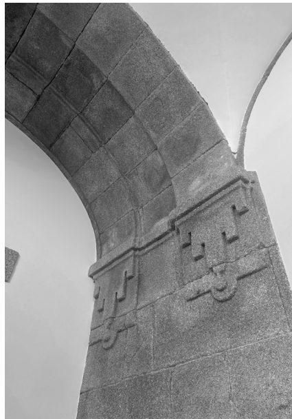
2.2.12 Imagen de detalle de arca- da exterior (2025)
