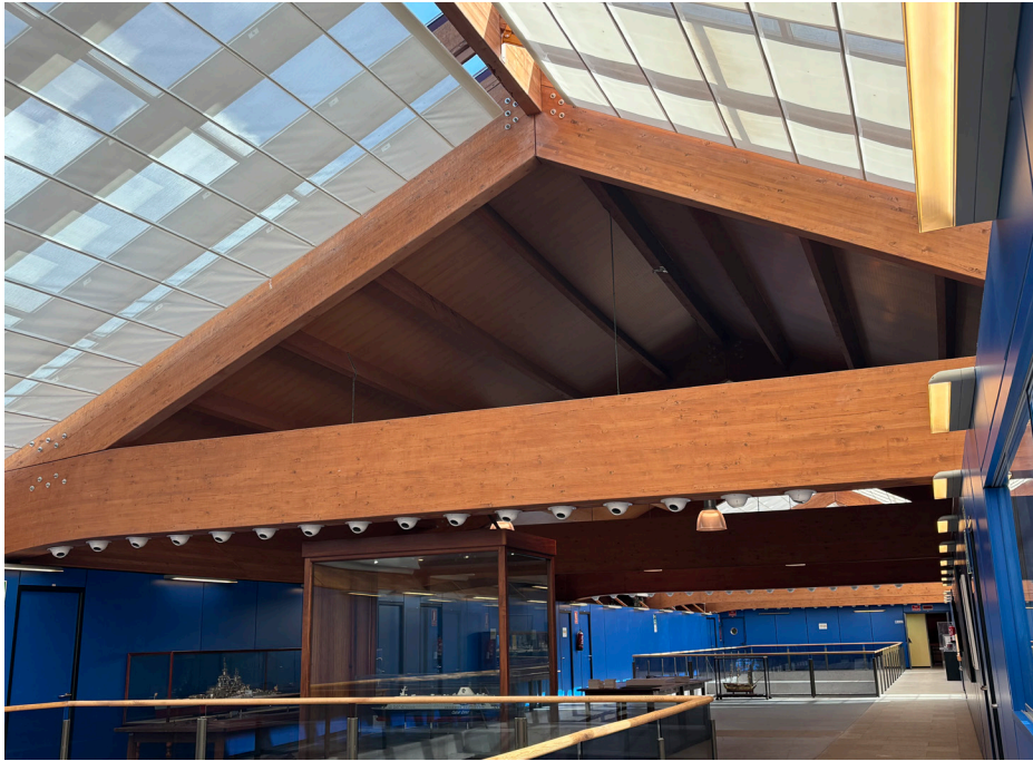
2.3.30 Imagen de la cubierta del patio de Las Herrerías (2025)
