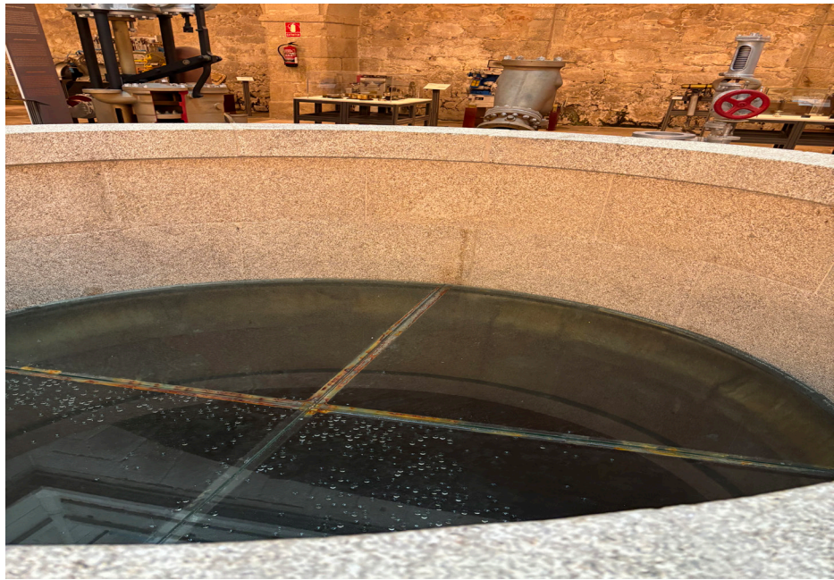
2.3.11 Imagen del pozo del edificio Las Herrerías (2025)
