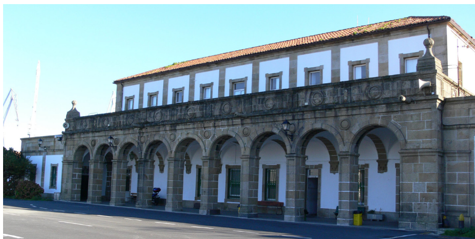
2.2.4 Imagen de la fachada principal (s.f)
