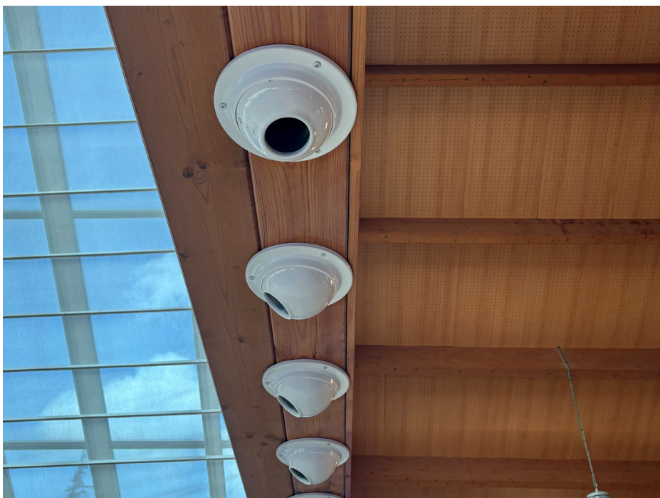
2.3.31 Imagen de las toberas de planta bajo cubierta (2025)
