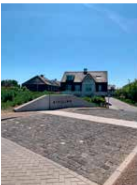
Figura 3.33: Paso elevado por la barrera de inundación. Fuente: Elaboración propia, 2025
