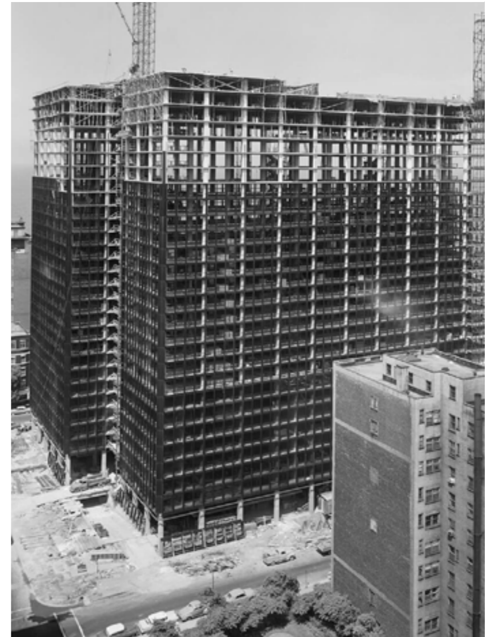
Figura 34. Fotografía del proceso de construcción
