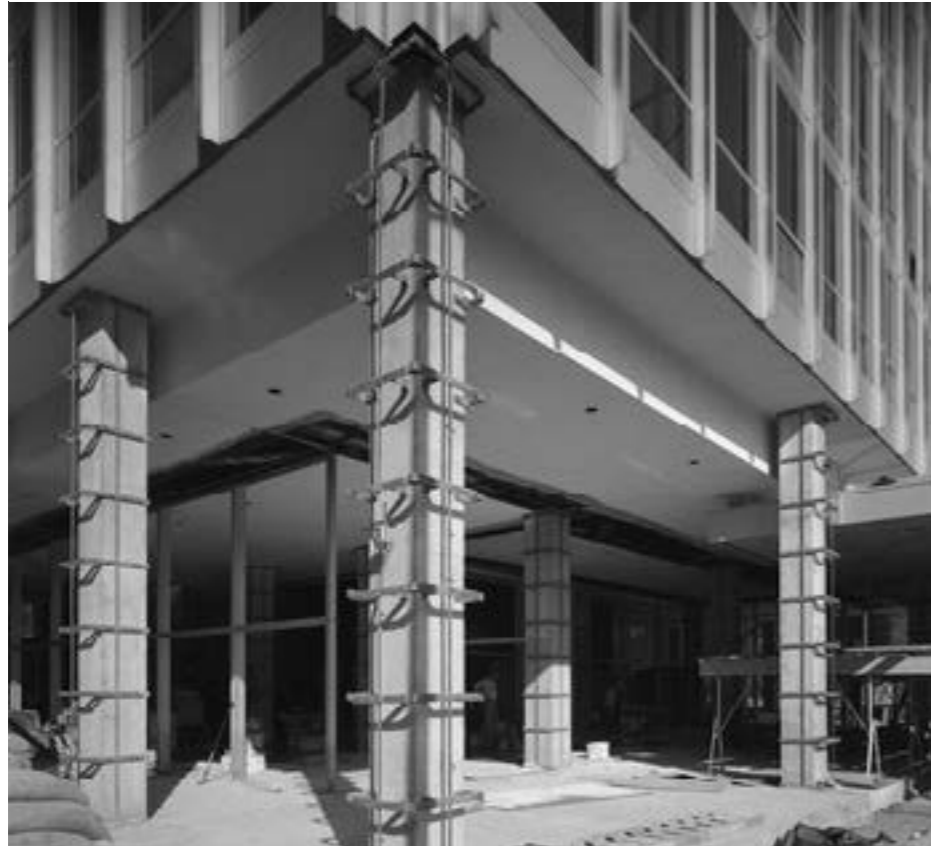
Figura 49. Proceso de construcción Lakeview
