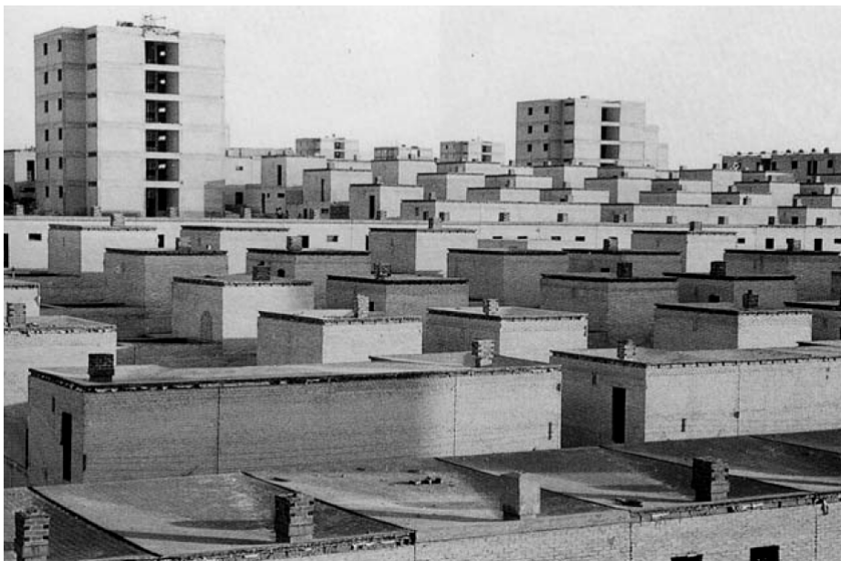
Fig. 3.4 Vista aérea de las diferentes tipologías de vivienda en Caño Roto
