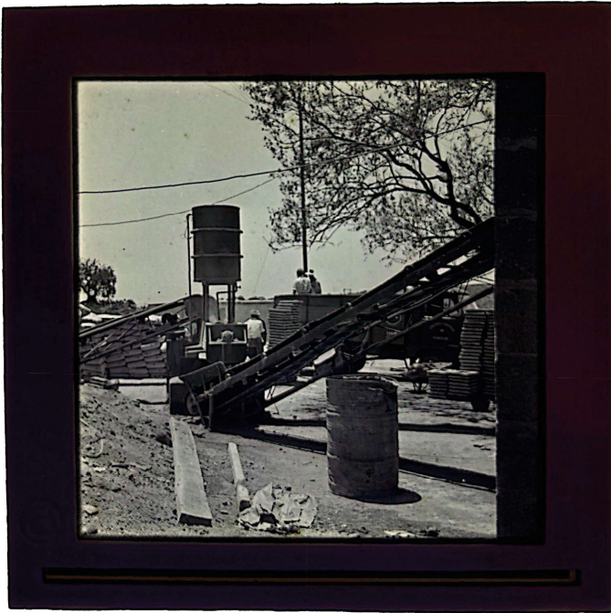
fpt.c.1_Proceso de construcción de sistema TABIBLOC
