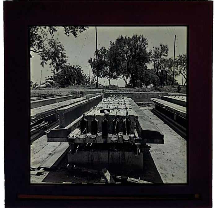
fpt.c.2_Elementos constructivos para construcción de forjados
