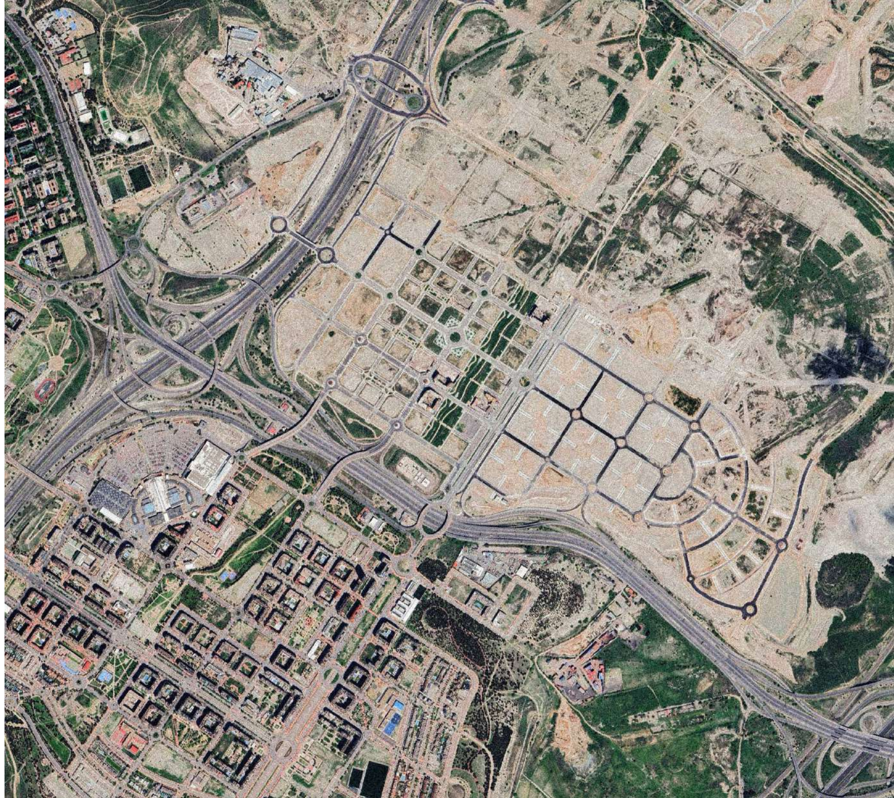
Fig. 3.1.11. Estado actual obras de urbanización en Los Berrocales. Fuente: Vuelo Airbus 2025. Google Earth
