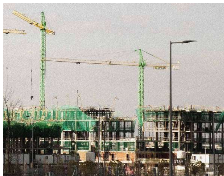
Fig. 3.1.8. Obras de edificación en Los Berrocales. Fuente: elaboración propia.
