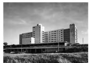
1.6 Fotografía del Hospital Saint-Lô en 1956. Modelo «Torre y Basamento»
