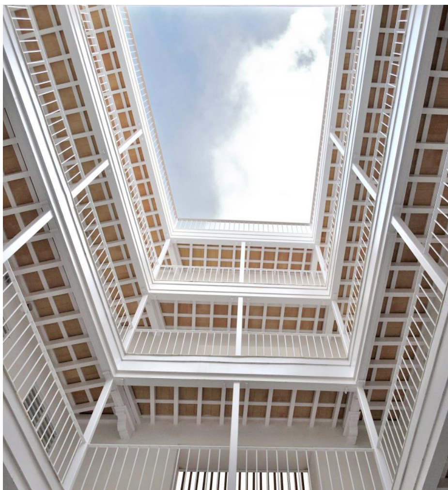
Fig 3.9. Patio rehabilitado, Casa de Juan Paje
