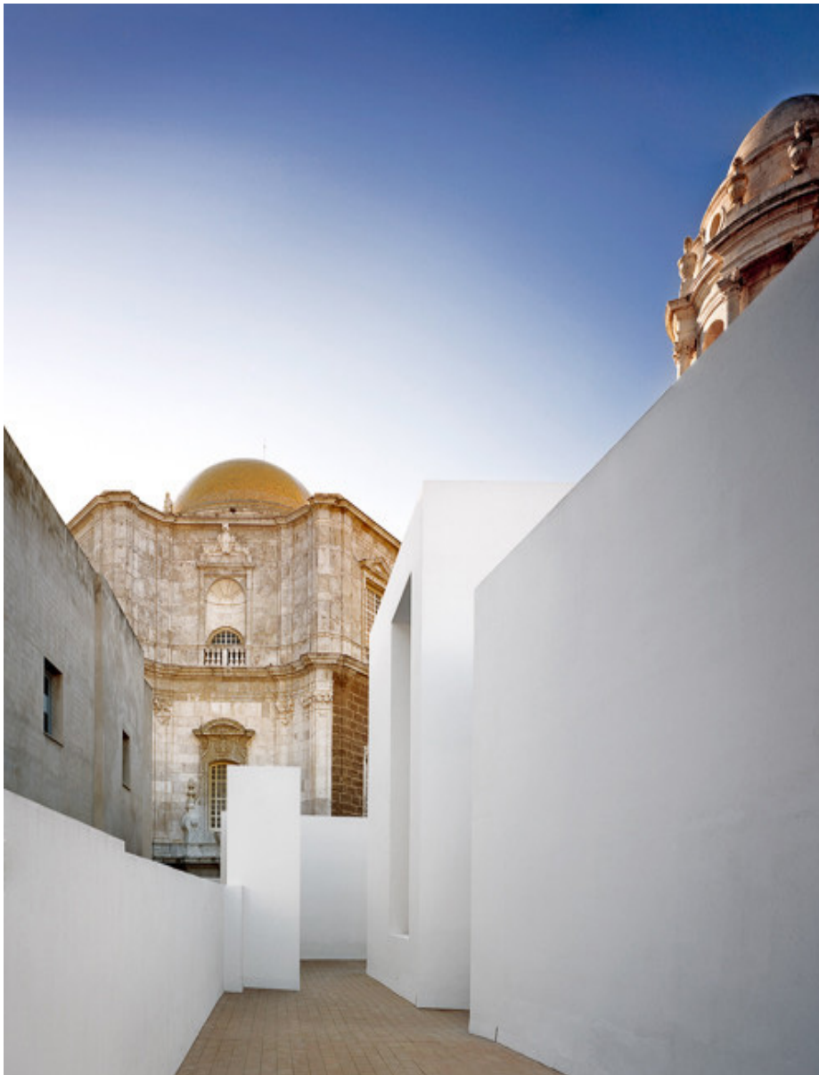
Fig 3.5. Rehabilitación viviendas de realojo.
