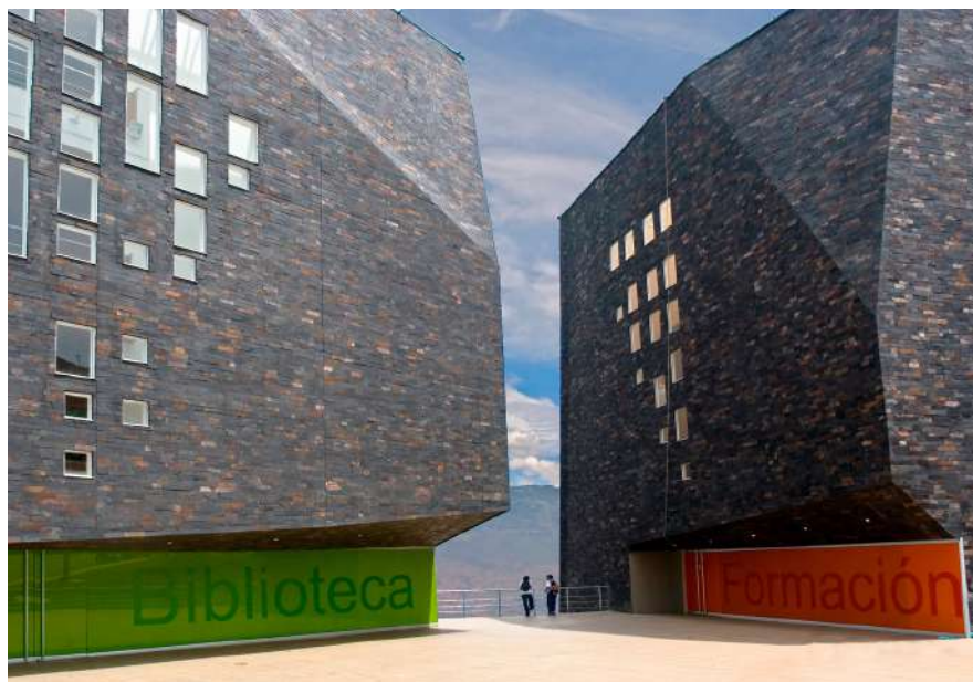
[6] Edificios de Biblioteca y Formación vistos desde la explanada de la plaza-mirador que los une.
