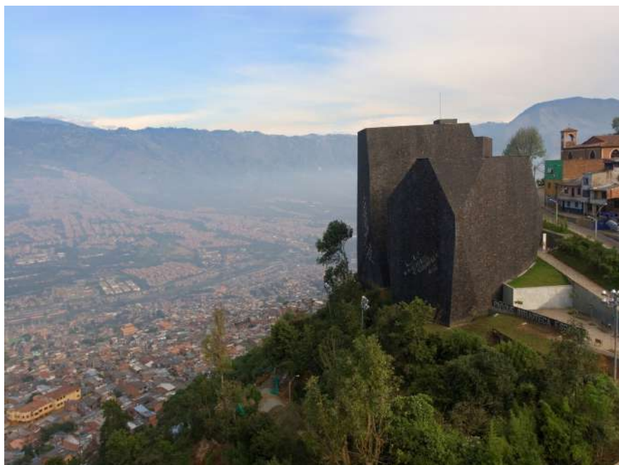
[2] Vista de los edificios del Parque Biblioteca España Santo Domingo Savio.
