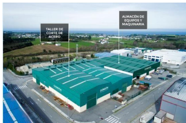
Ilustración 37: Instalaciones de procesamiento de acero y almacén del Astillero GONDÁN
