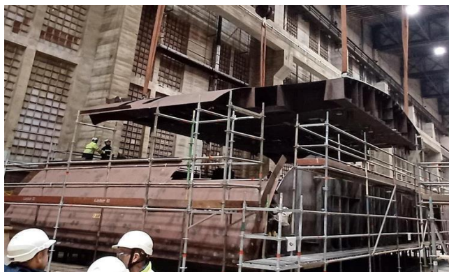
Ilustración 12: Construcción de un bloque en la fase de prefabricación
