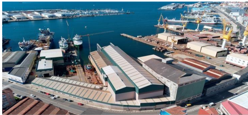
Ilustración 31: Instalaciones del astillero Armón Vigo
