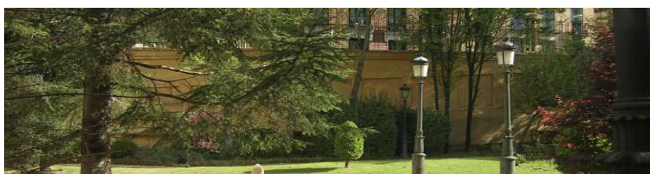
Fig 72. Cerramiento del Palacio de Parcent.
