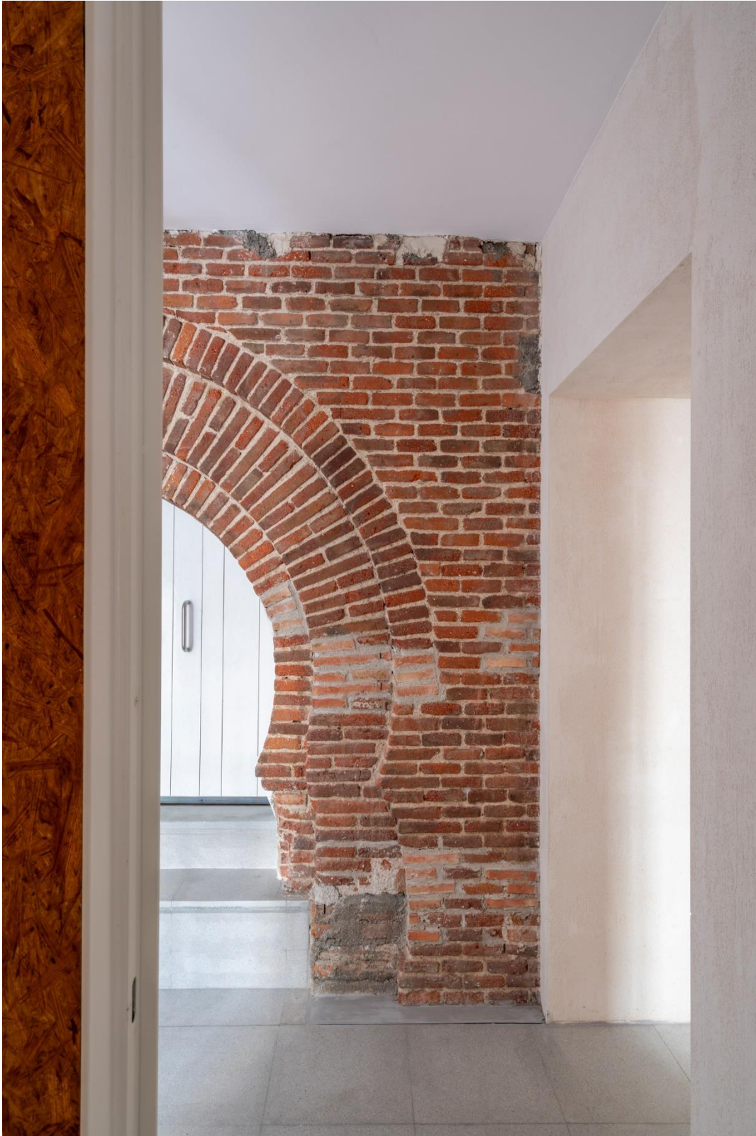
Figura 38: Vano con arco de tres roscas en ladrillo de tejar. Autor: Luis Así, 2024. Fotografía cedida por el arquitecto Juan Ruescas.
