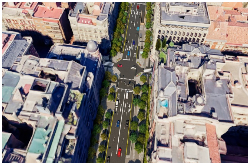
Figura 3.2: Vista Aérea de Calle Ortega y Gasset. Google Maps.
