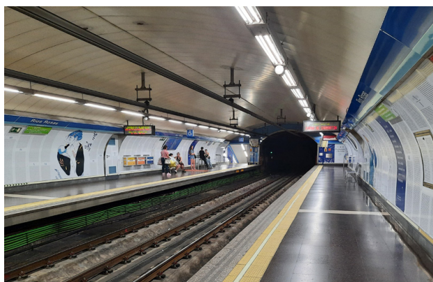
4.12. Andén de la línea 1 de la estación de Ríos Rosas
