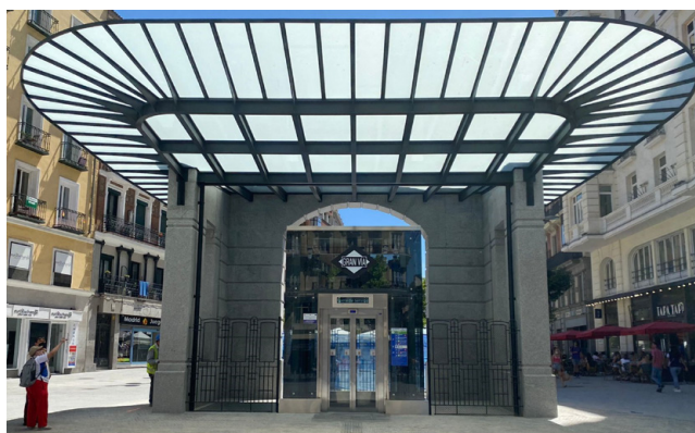
4.3. Templete actual de Gran Vía
