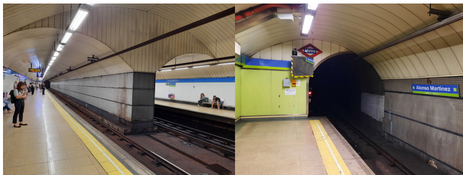
4.16. (Izquierda) Andén de la línea 10 de la estación de Alonso Martínez
