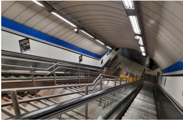
4.31. Túneles del transbordo de Cuatro Caminos
