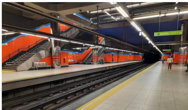
4.20. Andén de la línea 1 de la estación de Bambú
