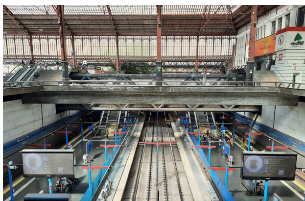
4.26. Andenes de las líneas 6 y 10 de la estación de Príncipe Pío
