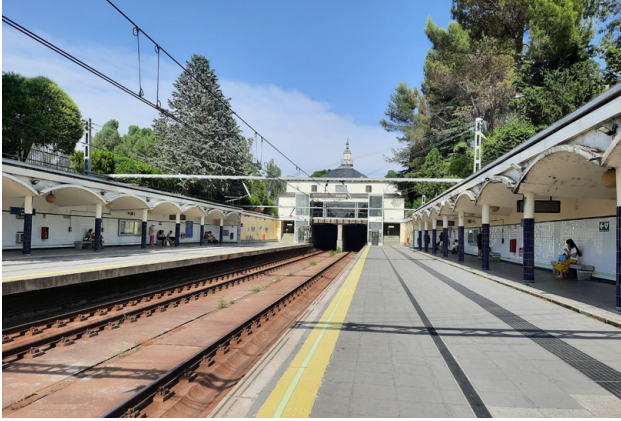
4.27. Andén de la línea 10 de la estación de Lago
